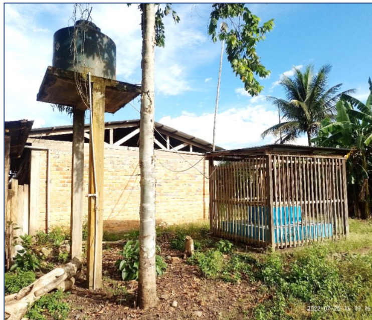
Foto 4. Tanque elevado para el almacenamiento de agua para consumo humano.
