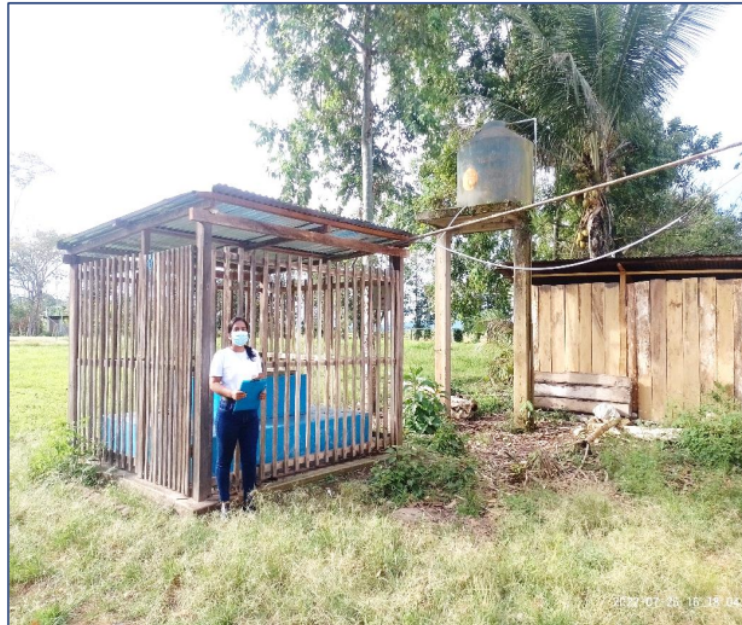
Foto 3. Sistema de abastecimiento de agua.
