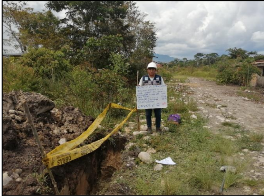
Foto N° 1. Excavación de calicatas, para la extracción de muestras.
