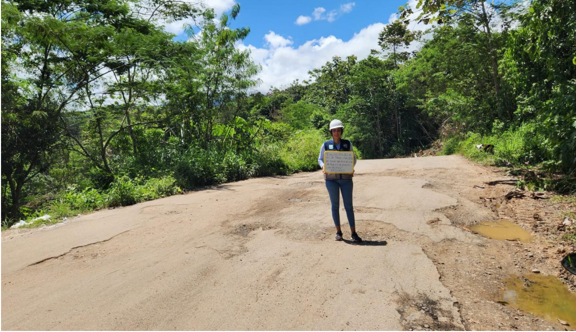
Figura 13. Progresiva 0+810: Baches
