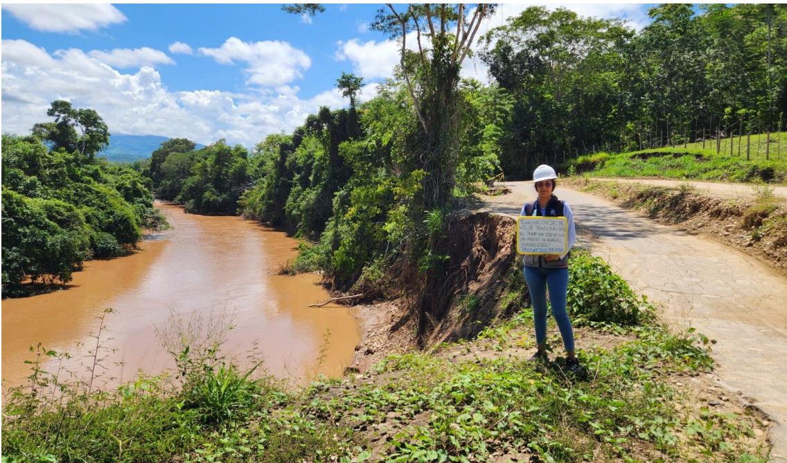
Figura 14. Progresiva 4+180: Erosión
