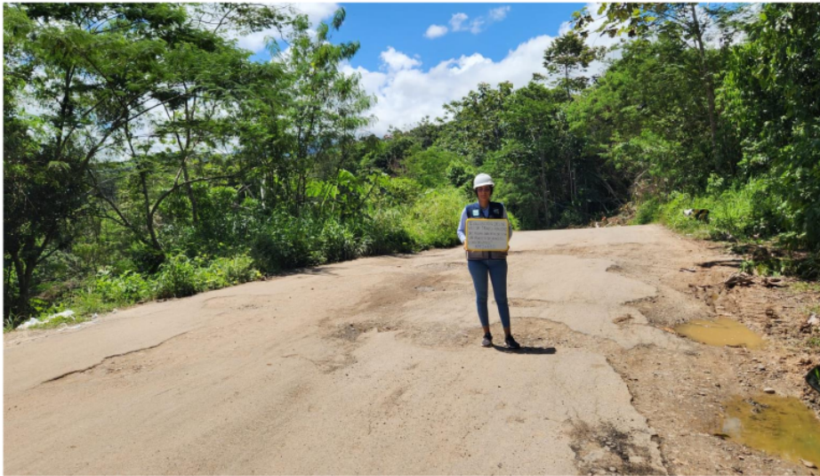
Figura 13. Progresiva 0+810: Baches
