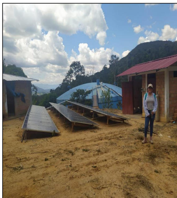
Fotografía 4. Reservorio de la captación de agua de la Microcuenca Juninguillo. Coordenadas: 290093,991E; 9334068,134N.
