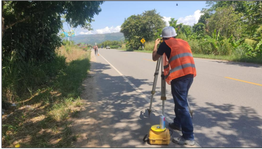
Figura 29. Recolección de datos con mira y nivel Tramo 1 (2+000 KM - 2+320 KM). Fuente: 2 Elaboración propia.
