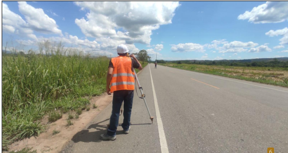
Figura 33. Recolección de datos con mira y nivel Tramo 3 (9+500 KM – 9+820 KM). Fuente: Elaboración propia.
