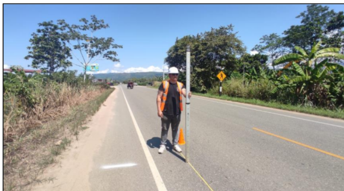
Figura 10. Recolección de datos con mira y nivel cada 250 mm, usando de referencia una cinta métrica (Tramo 2).
