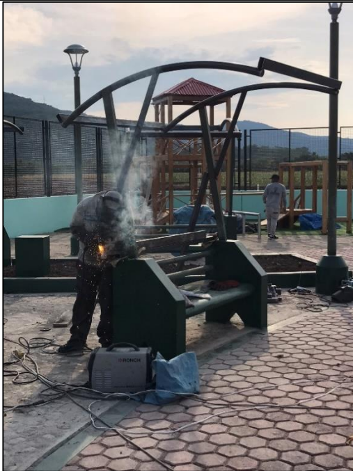
Fotografía N° 11: Desarrollo de las actividades de instalación de los tijerales metálicos de las bancas con techo.
