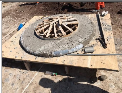
Fotografía N° 02: Desarrollo de las actividades de encofrado de las bancas circulares de concreto.
