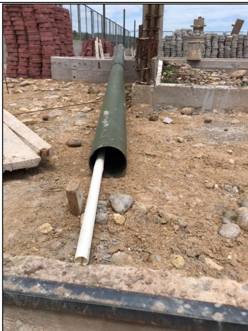
Fotografía N° 13: Vista de la estructura metálica tubular constituida en la farola ornamental, con el debido uso de la tubería para electricidad.
