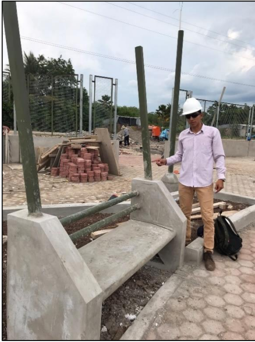
Fotografía N° 09: Desarrollo de las actividades de tarrajeo de muros C:A 1:5 E=1.5cm de las bancas con techo.
