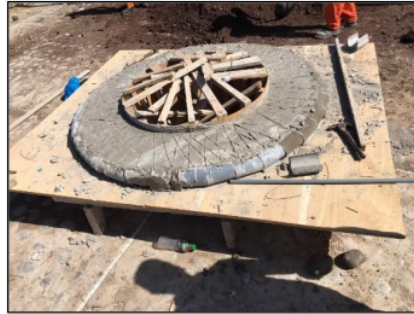
Fotografía N° 02: Desarrollo de las actividades de encofrado de las bancas circulares de concreto.
