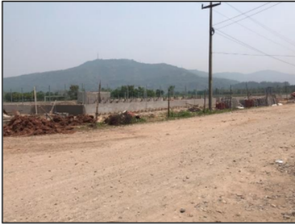
Fotografía N° 01: Ubicación del proyecto en desarrollo en la localidad de Villanueva del Río – Picota.
