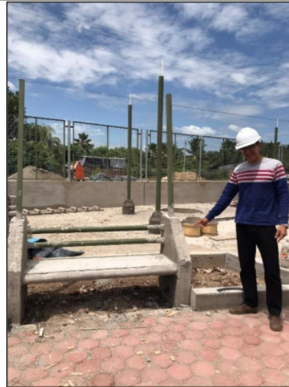
Fotografía N° 08: El tesista Bach. Frank Stevie Romero Ramírez constatando el desarrollo de las actividades de desencofrado de las bancas con techo.
