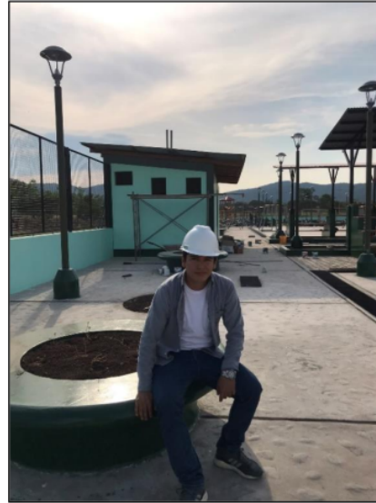
Fotografía N° 06: El tesista Bach. Dante Castillo Pérez constatando el acabado final de la pintura látex 2 manos en muros de las bancas circulares de concreto.
