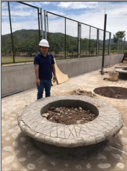
Fotografía N° 03: Desarrollo de las actividades de desencofrado de las bancas circulares de concreto.
