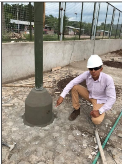
Fotografía N° 15: Vista del tarrajeo de muros C:A 1:5 E=1.5 cm en la base de las farolas ornamentales.
