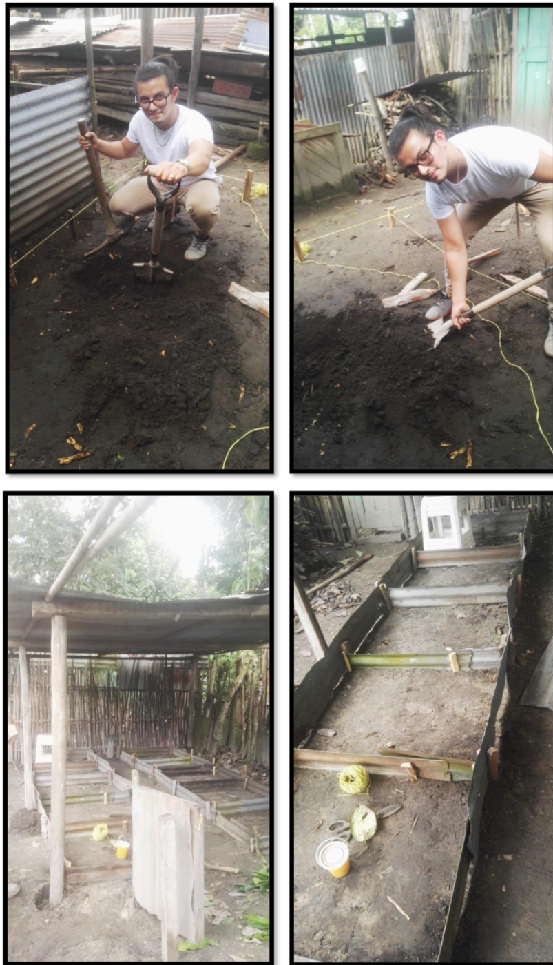
Figura 3. Construcción de instalaciones para ejecución del estudio 12
