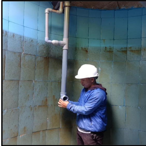
Fotografía N° 2. Unión de la tubería de ingreso a la tubería de rebose.
