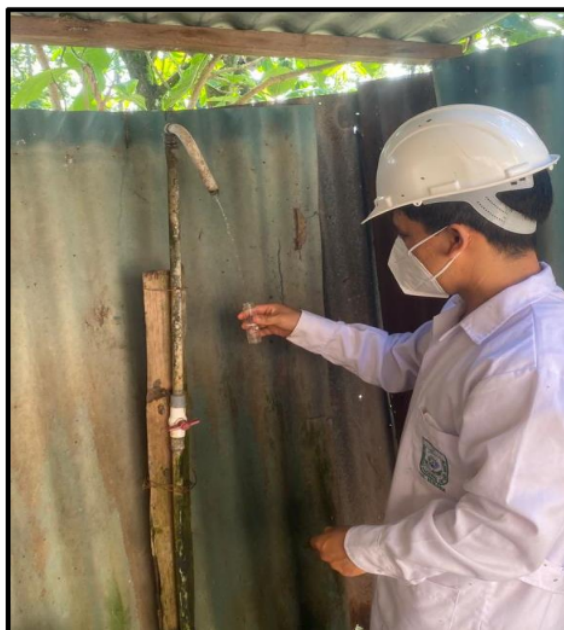
Fotografía N° 8. Toma de muestra para medir el cloro residual en la primera vivienda.
