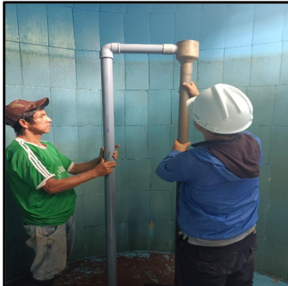
Fotografía N° 2. Unión de la tubería de ingreso a la tubería de rebose.
