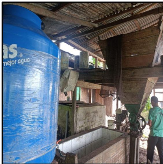
Fotografía N° 15. Instalación del tanque rotaplas de 1100 litros para almacenamiento de agua sobrante del reservorio dirigido al lavado de "café".
