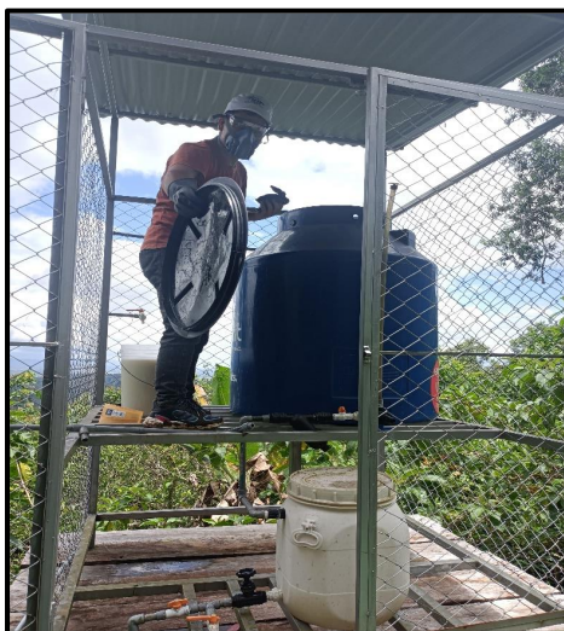
Fotografía N° 4. Preparación de la solución madre para la cloración del agua.
