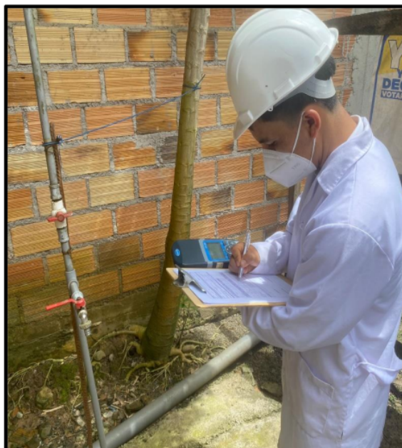
Fotografía N° 13. Monitoreo de cloro residual en la última vivienda.
