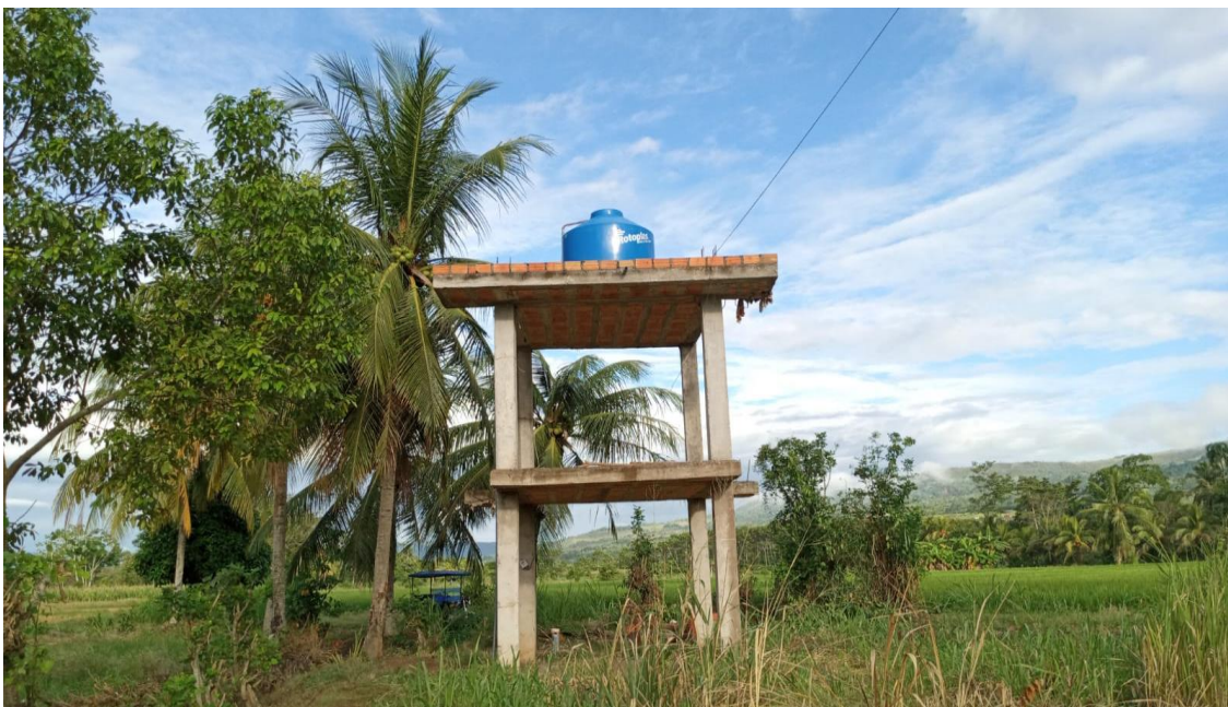
Figura 24 Ubicación de tanque elevado 2500 litros
