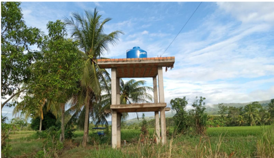
Figura 24 Ubicación de tanque elevado 2500 litros
