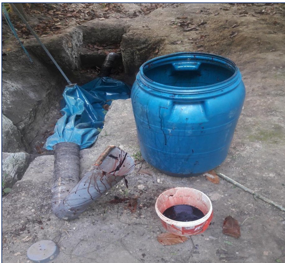
Figura 9. Cargado del biodigestor con las aguas residuales del matadero.
