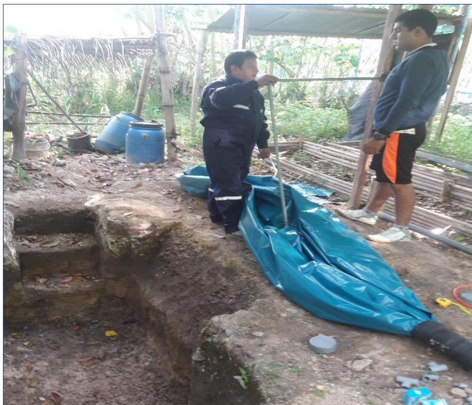
Figura 5. Colocación del tubo de ingreso de residuos del matadero del biodigestor
