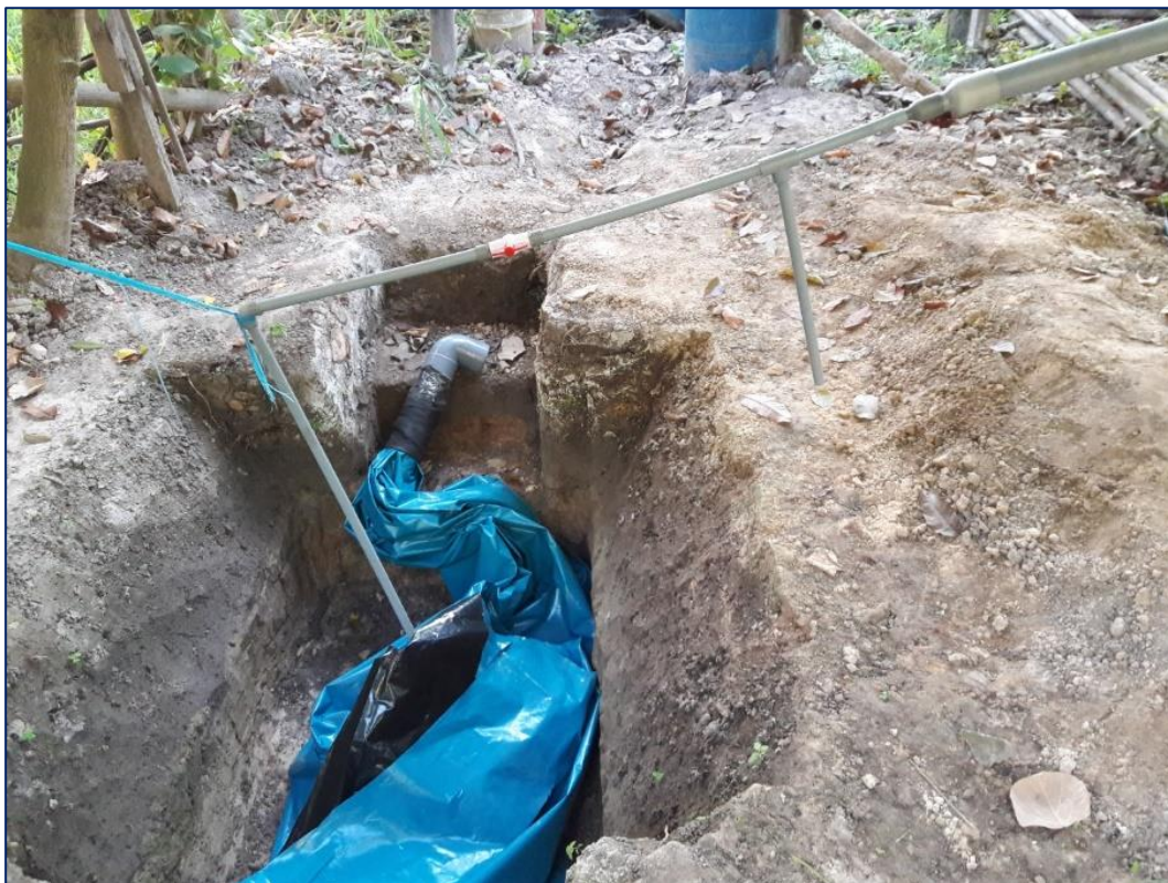
Figura 12. Colocada de tubos para el llenado del biodigestor.
