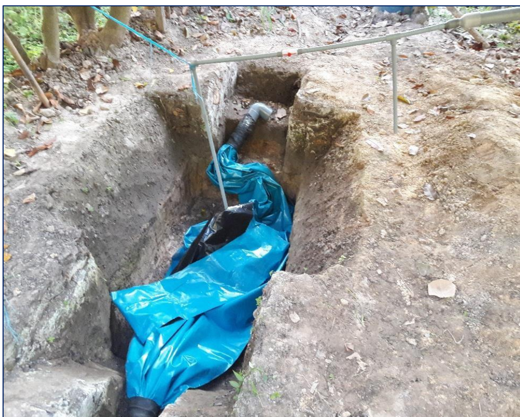
Figura 8. Instalación del biodigestor de mangas.
