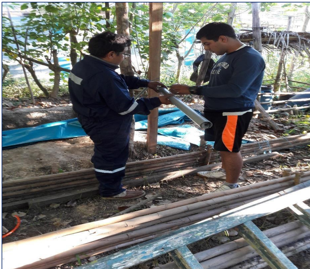
Figura 7. Colocación de la trampa en el tubo de la salida del gas para mitigar los olores.
