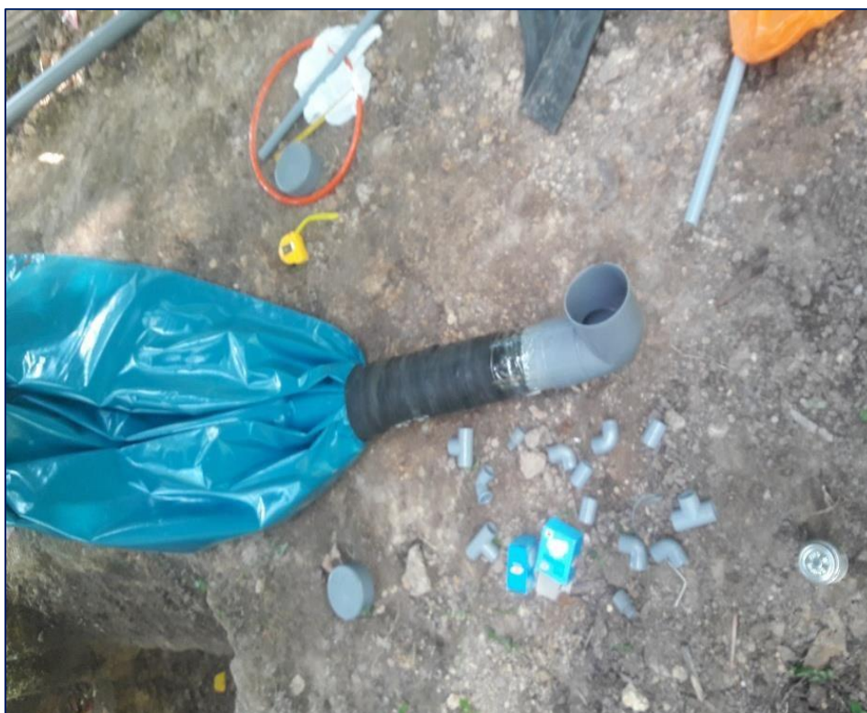
Figura 6. Colocación del tubo de salida de gas.
