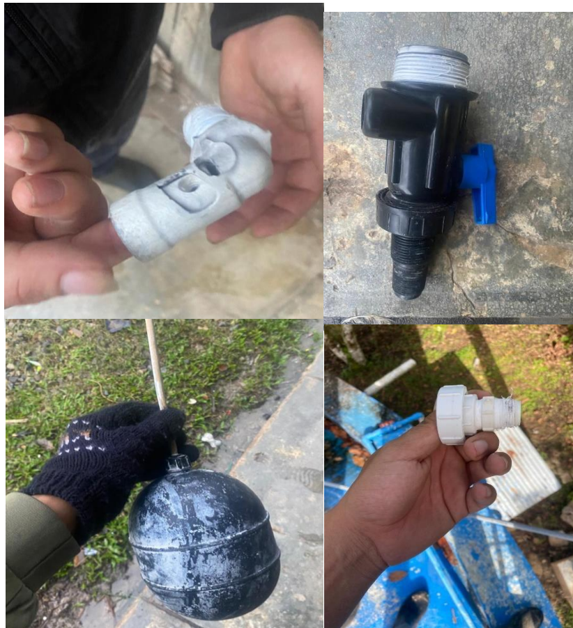
Figura 18 Diagnóstico inicial del sistema de cloración
