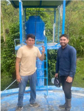
Figura 25 Monitoreo de cloro residual junto al ATM
