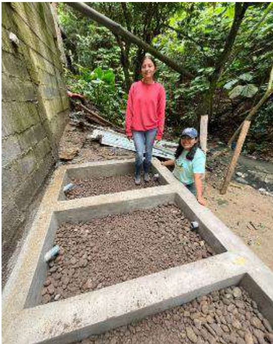
Fotografía 7. Proceso constructivo del sistema de tratamiento mediante humedales artificiales.
