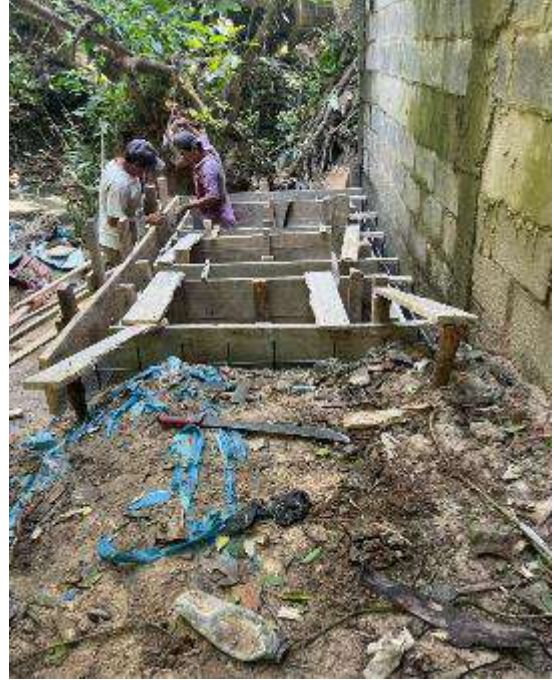
Fotografía 6. Proceso constructivo del sistema de tratamiento mediante humedales artificiales.
