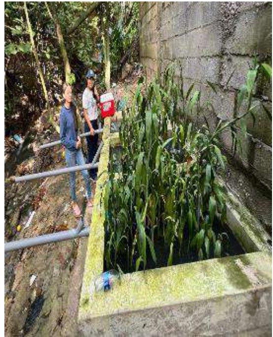
Fotografía 12. Sistema de tratamiento mediante humedales artificiales con Dracaena sandariana construido y puesto en funcionamiento.
