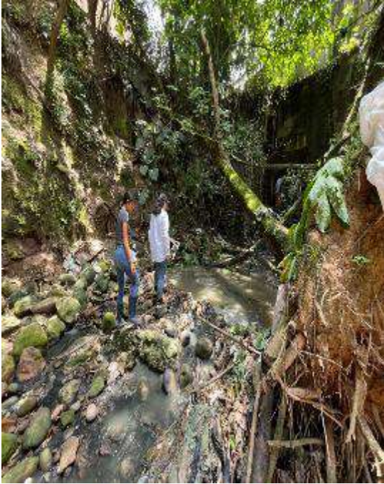
Fotografía 5. Evaluación de las condiciones del área para la instalación del sistema de tratamiento mediante humedales artificiales.
