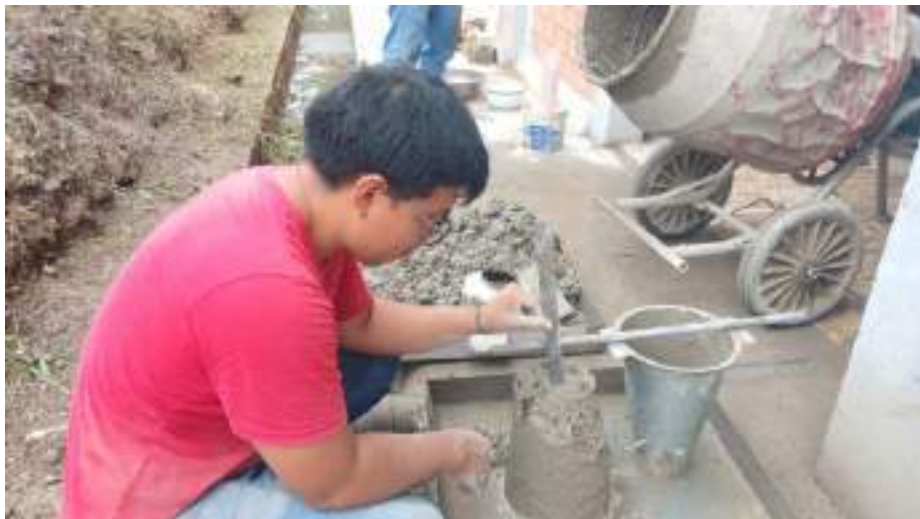
Imagen 2. Prueba de asentamiento
