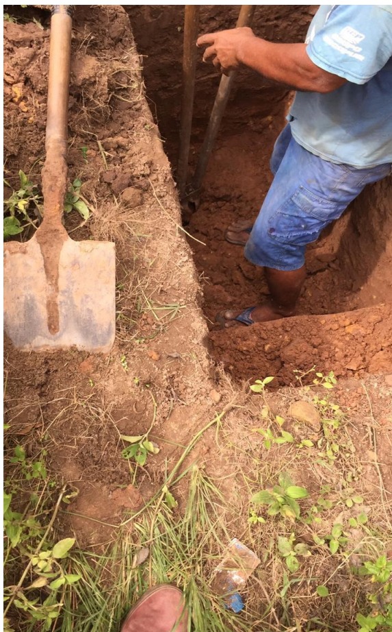
Exacvación de una Calicata en proceso.
