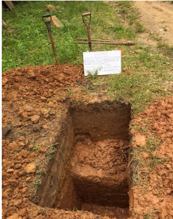
Calicata finalizada, se observa humedad por la lluvia
