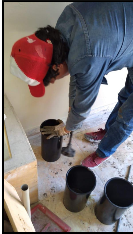
Foto 39: Uso del mazo de goma para quitar aire de la mezcla de concreto
