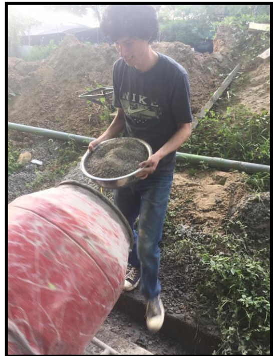
Foto 28, 29, 30 y 31: Colocación de materiales en el trompo para la elaboración de concreto patrón y con adición de PET
