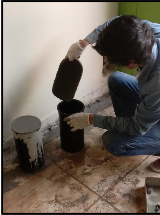
Foto 37: Colocación de mezcla de concreto en la probeta
