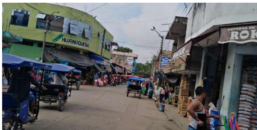
Evidente falta de estacionamiento en los lados del mercado
