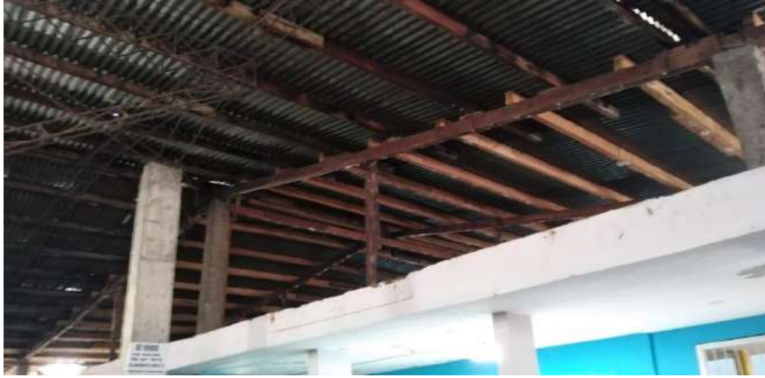
Estructuras de madera en mal estado, filtraciones de agua en tiempo de lluvias
