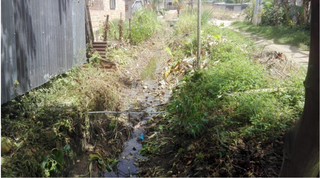
Figura A-01. En la imagen se aprecia las cunetas construidos empíricamente por los pobladores ubicados en el Jirón Picaflores C-02. ( Fuente: Elaboración propia).
