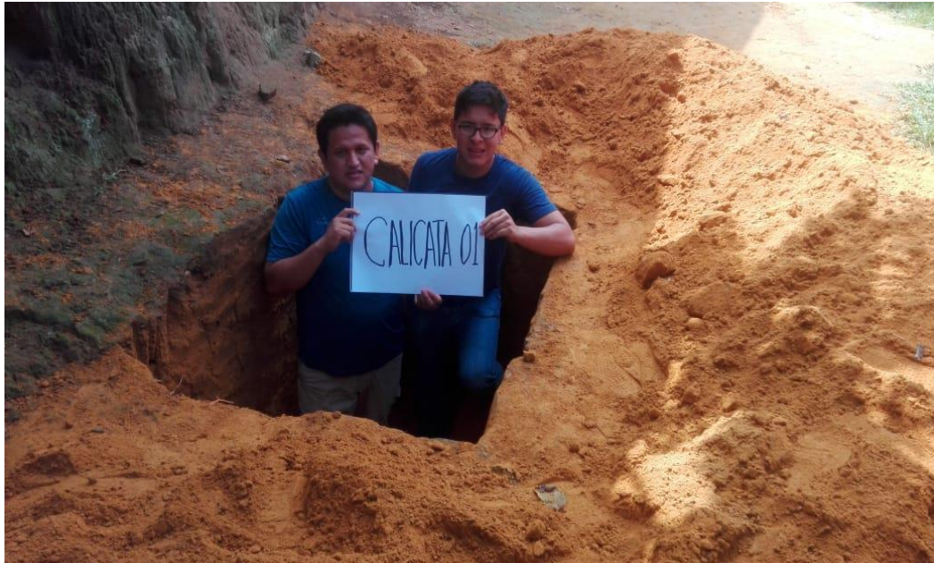
Figura A-05. En la imagen se aprecia la calicata excavada para tomar muestras, y luego realizar los estudios respectivos para el diseño estructural. (Fuente: Elaboración propia).
