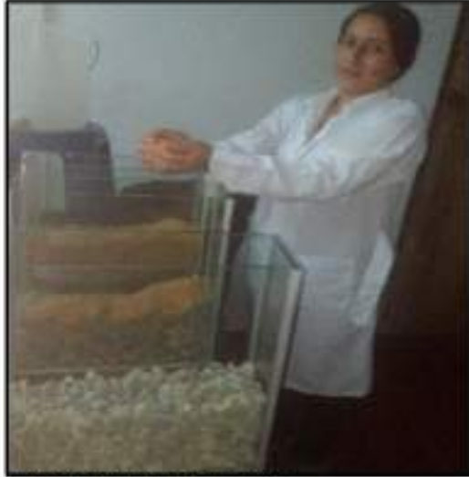
Imagen 5: Construcción del Lombrifiltro Fuente: (TESISTA MRC)
