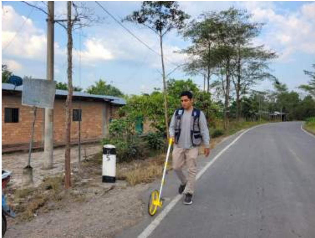
Foto 17: Inspección visual de la vía en estudio en la progresiva km 5+000
