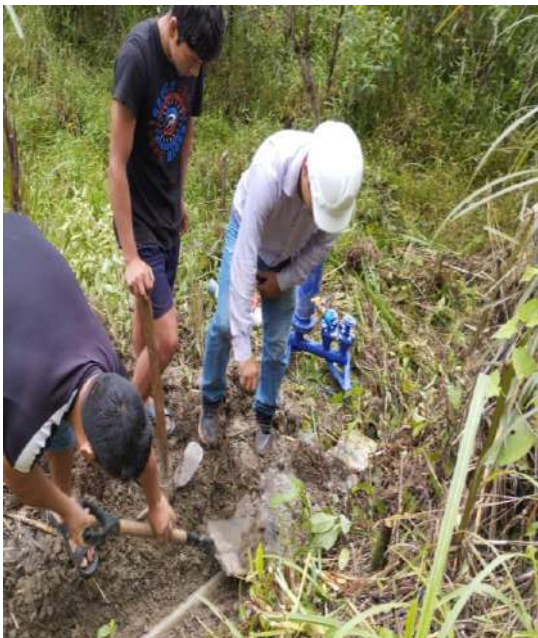
Fotografía 3. Acondicionamiento del área para la ubicación de la bomba de ariete hidráulico.
