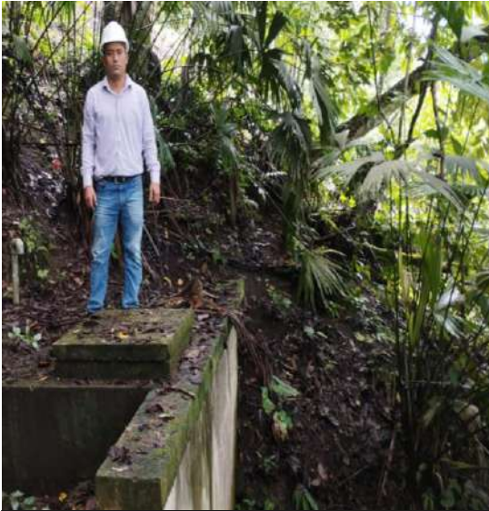
Fotografía 1. Captación del sistema de abastecimiento de agua del centro poblado El Oriente.
