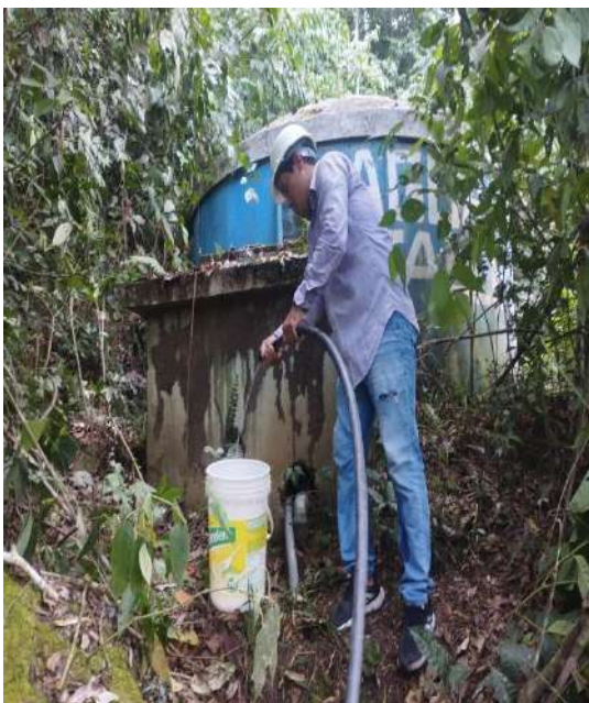
Fotografía 7. Medición de caudal de bombeo en el reservorio del centro poblado El Oriente.
