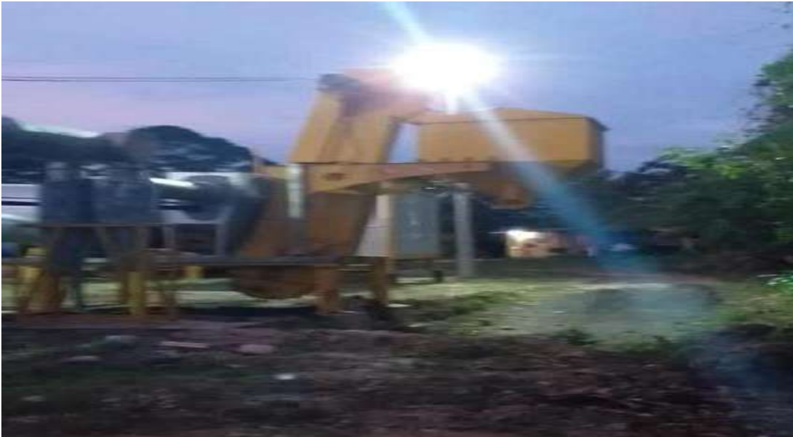
Figura 4 Elevador de la carpeta asfáltica y descarga a volquetes.
