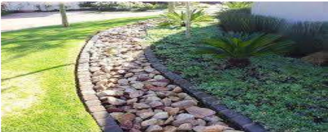
Figura 3 Zanjas de infiltración.
