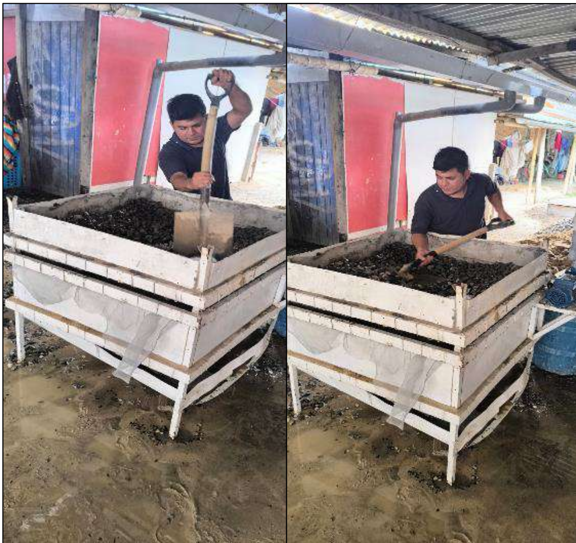
Fotografía 1 y 2. Elaboración de los sistemas de drenaje.
