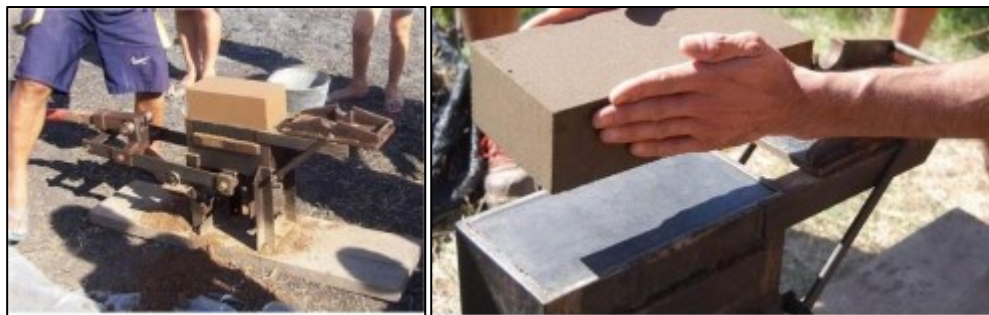
Figura 5: Elaboración del BTC en la CINVA RAM. (Fuente: Criativa, 2015)
