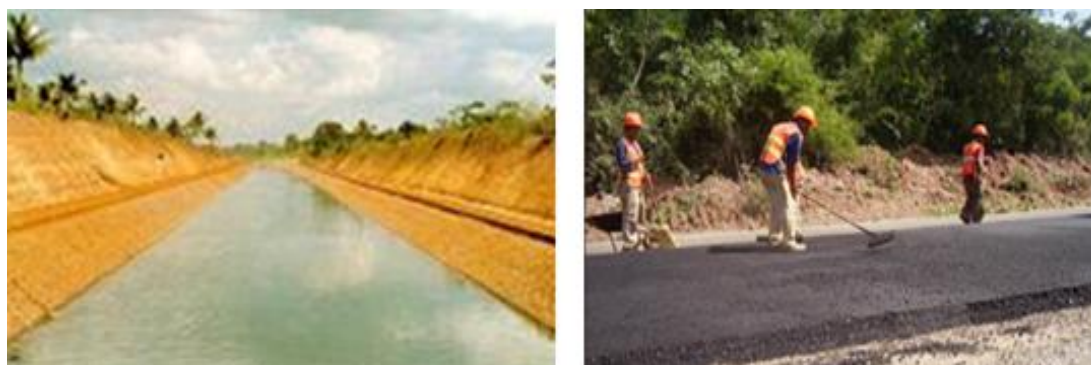
Figura 23. Construcción de canales y pavimentos. (Fuente: Martinez, E. Guía de Mecánica de Suelos I, 2014)
