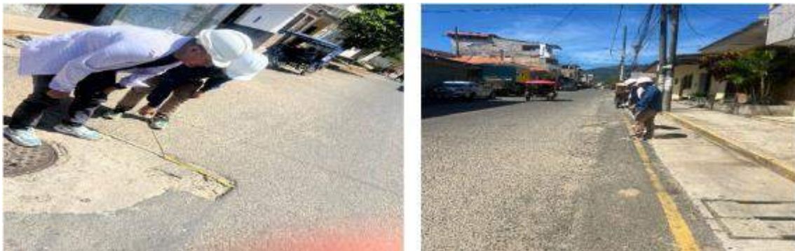
Figura 6 Características de las fallas superficiales
