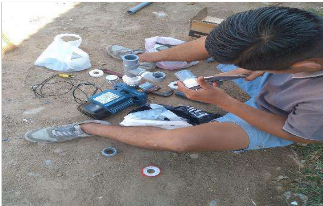
Fotografía 3. Construcción del sistema de filtros de piedra pómez.
