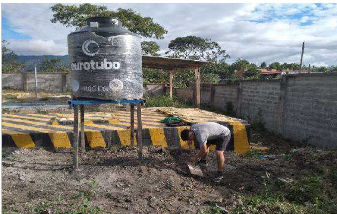
Fotografía 1. Acondicionamiento del terreno para la instalación del sistema de filtros de piedra pómez.
