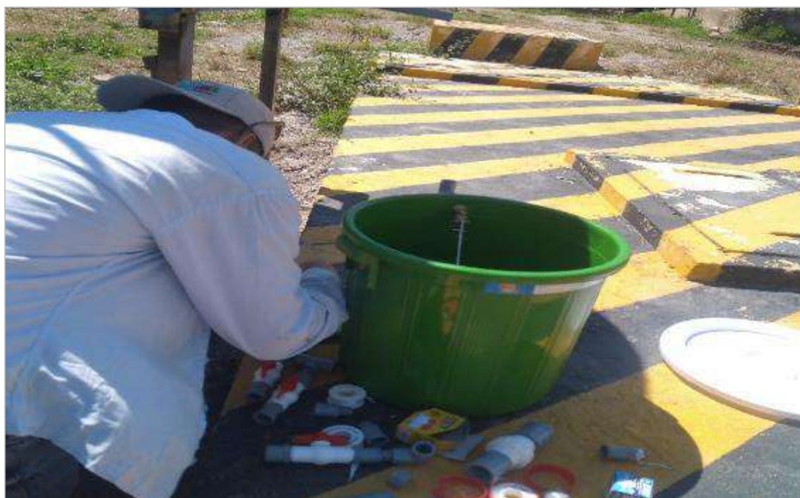
Fotografía 2. Construcción del sistema de filtros de piedra pómez.
