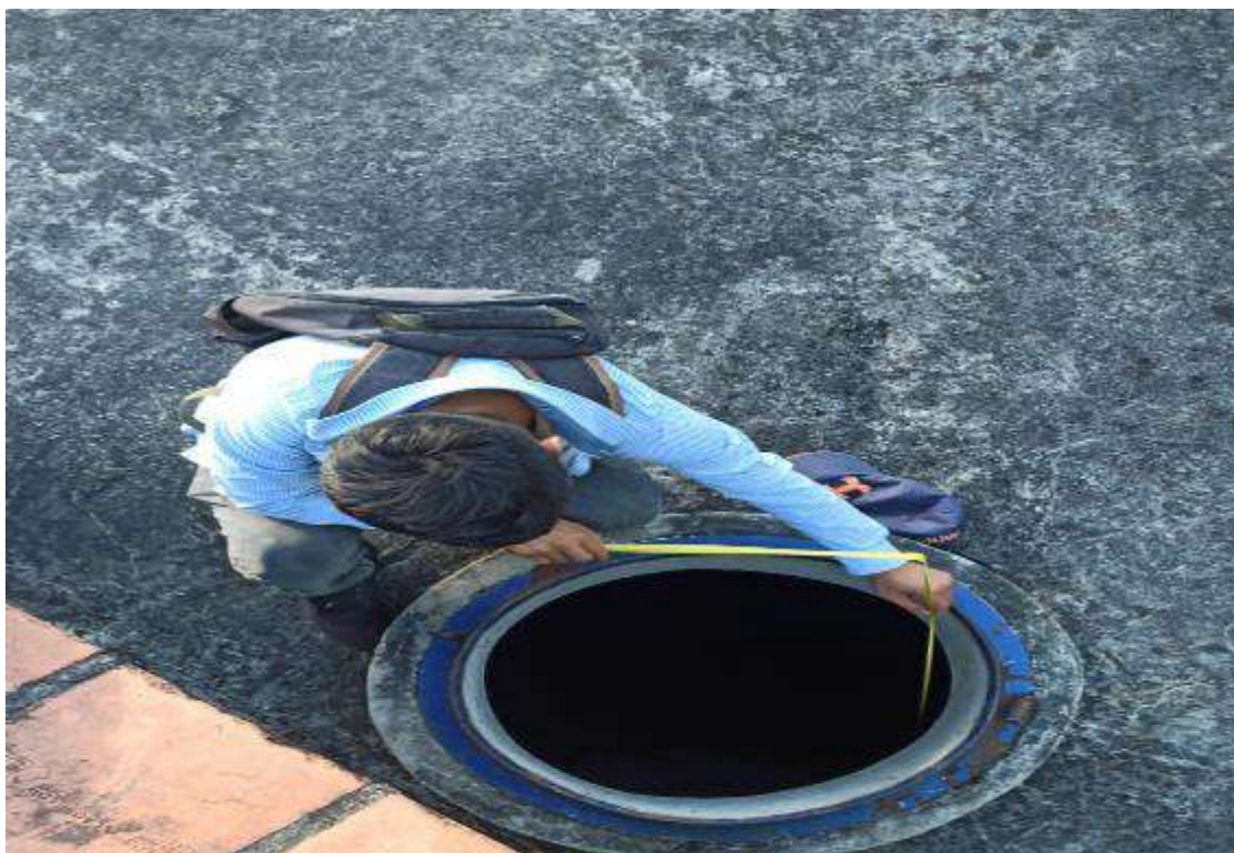
Fotografía 4. Medición de la altura en la cisterna de 500 m 3 .
