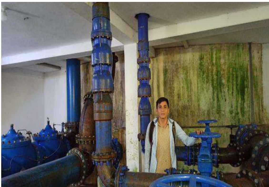
Fotografía 1. Succión de la bomba de impulsión.
