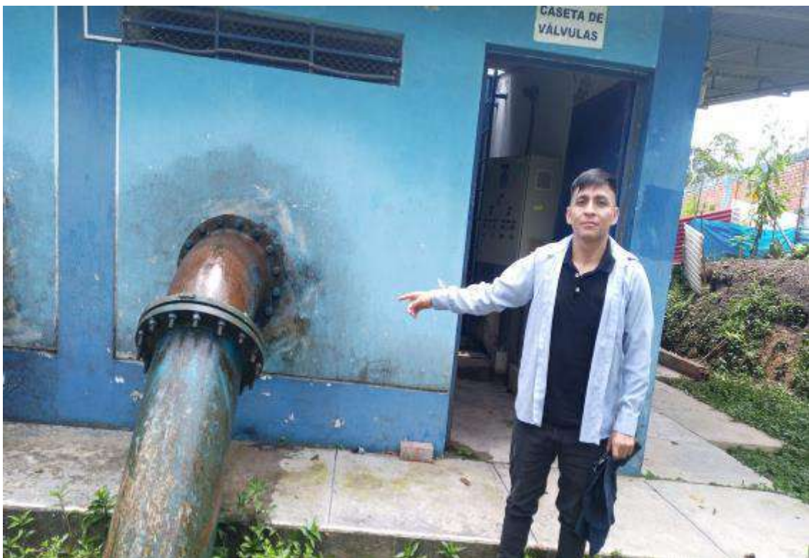
Fotografía 6. Ingreso de la tubería de impulsión al reservorio apoyado de 1 200 m 3 .
