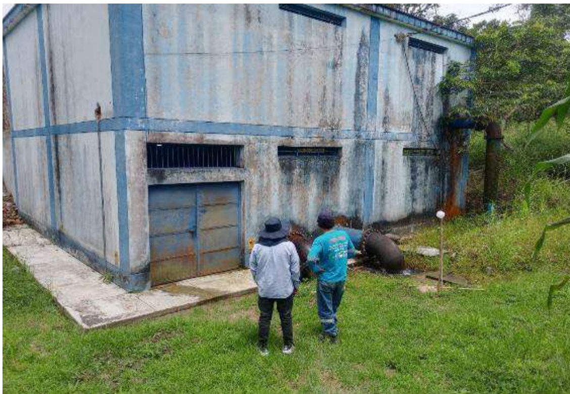
Fotografía 3. Parte externa de la caseta de bombeo.
