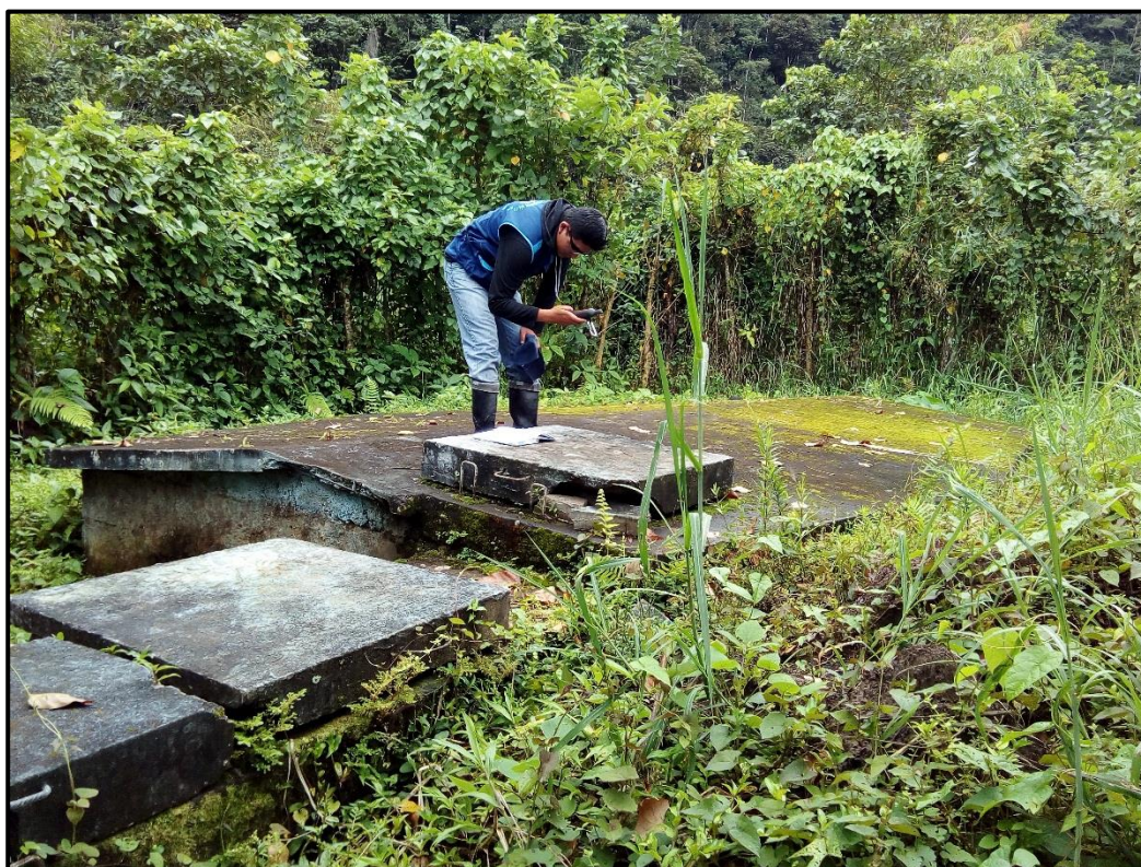
Foto 1 Vista panorámica de la captación existente
