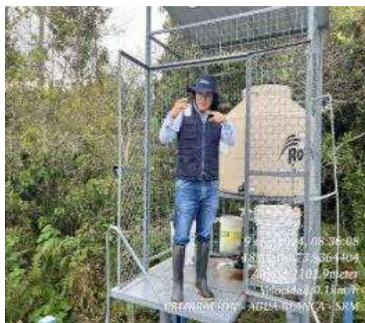
Foto N°2: SAP Santa Rosa Del Mirador optimización la dosis de cloro.
