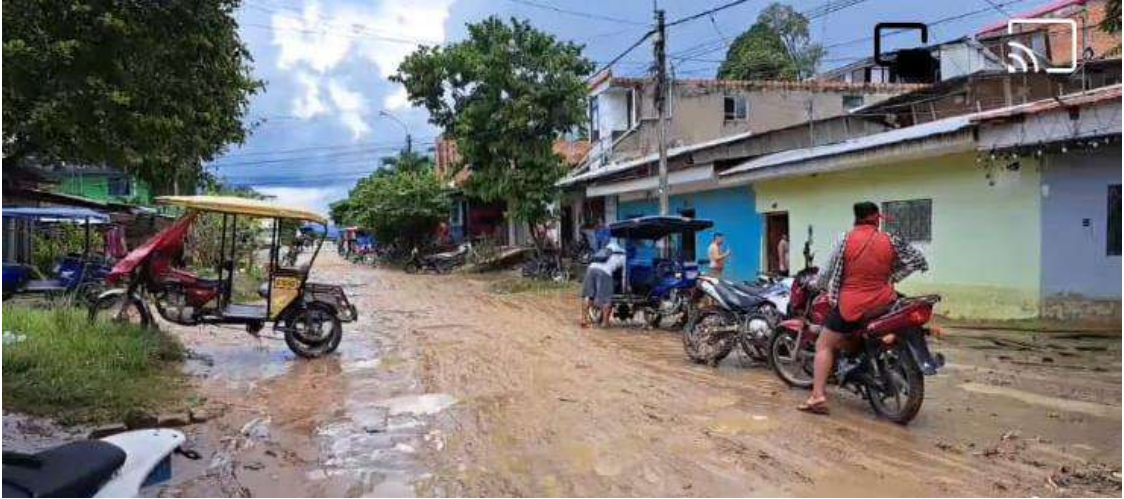
Foto 3: Calles en mal estado producto del mal sistema de drenaje a consecuencia de las intensas lluvias
