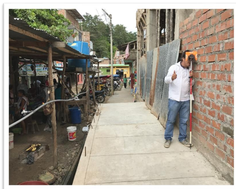
Figura 11: levantamiento topográfico en el Jr. Malecón C-04 y 05.
