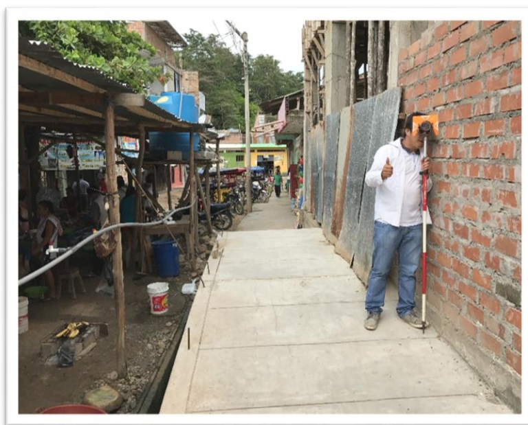
Figura 14: Vista fotográfica de ayudante con prisma, levantamiento topográfico en el Jr. Malecón C-04 y 05.
