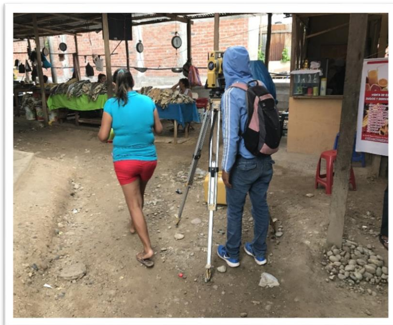
Figura 13: Se aprecia el Levantamiento Topográfico con Estación Total en Calle N° 04.
