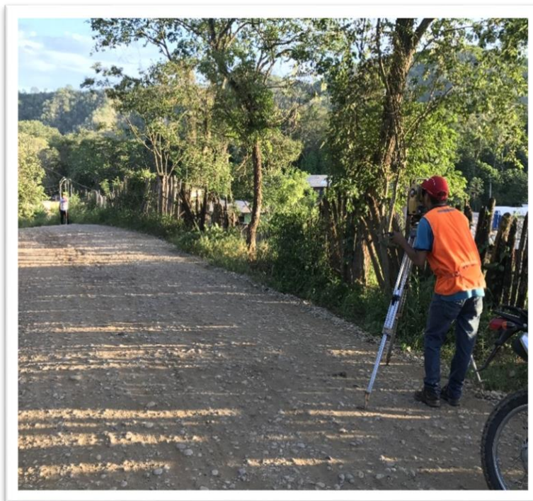
Figura 15: Se aprecia los trabajos de levantamiento topográfico en el Jr. Moquegua C-02.
