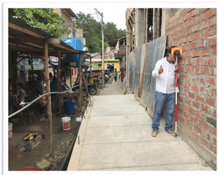
VISTA N°04: Vista fotográfica de ayudante con prisma, levantamiento topográfico en el Jr. Malecón C-04 y 05.
