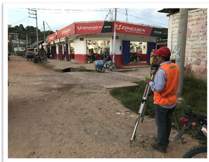
VISTA N°01: Levantamiento Topográfico con Estación Total en el Jr. Progreso C-01.
