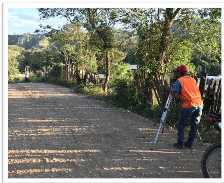
Figura 12: levantamiento topográfico en el Jr. Moquegua C-02.
