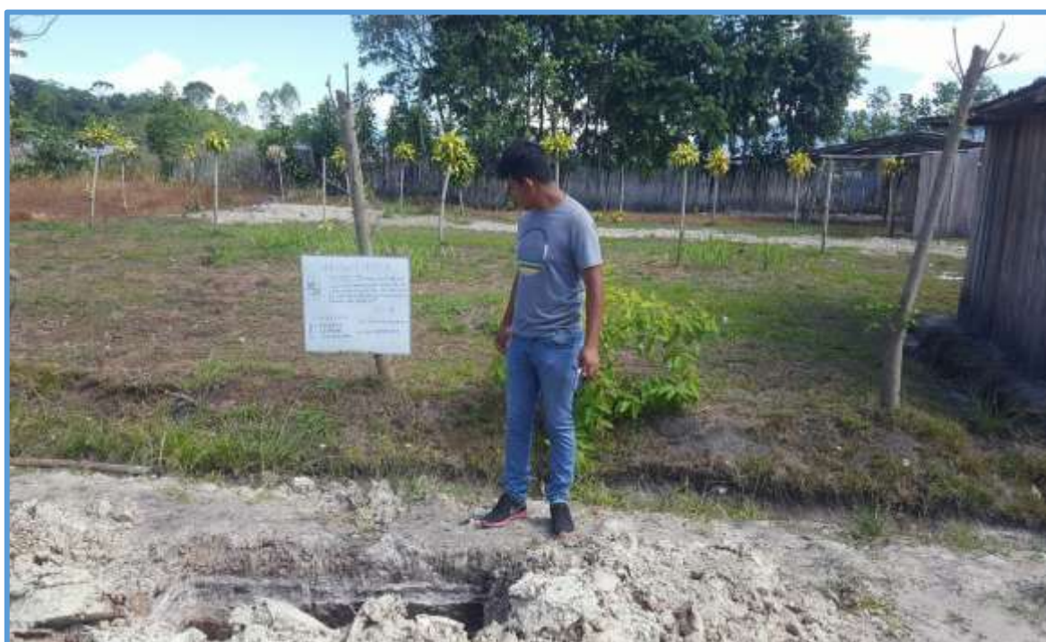
Foto 22: Véase en la imagen la excavación de la décima calicata (C-18) en el Jr. Prolongación Las Flores y Jr. El Pongo; N: 9320716, E:268990, A: 907 m.s.n.m.
