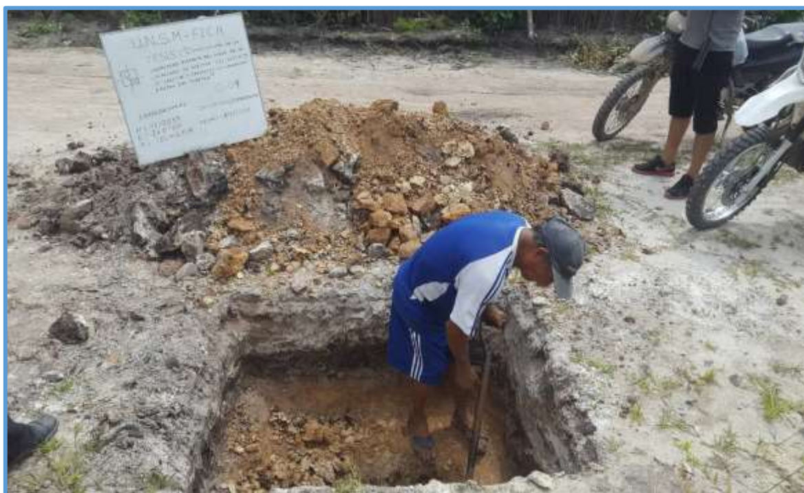
Foto 18: Véase en la imagen la excavación de la novena calicata (C-09) en el Jr. Oriente y Jr. Las Orquideas; N: 9320939, E:268766, A: 906 m.s.n.m.
