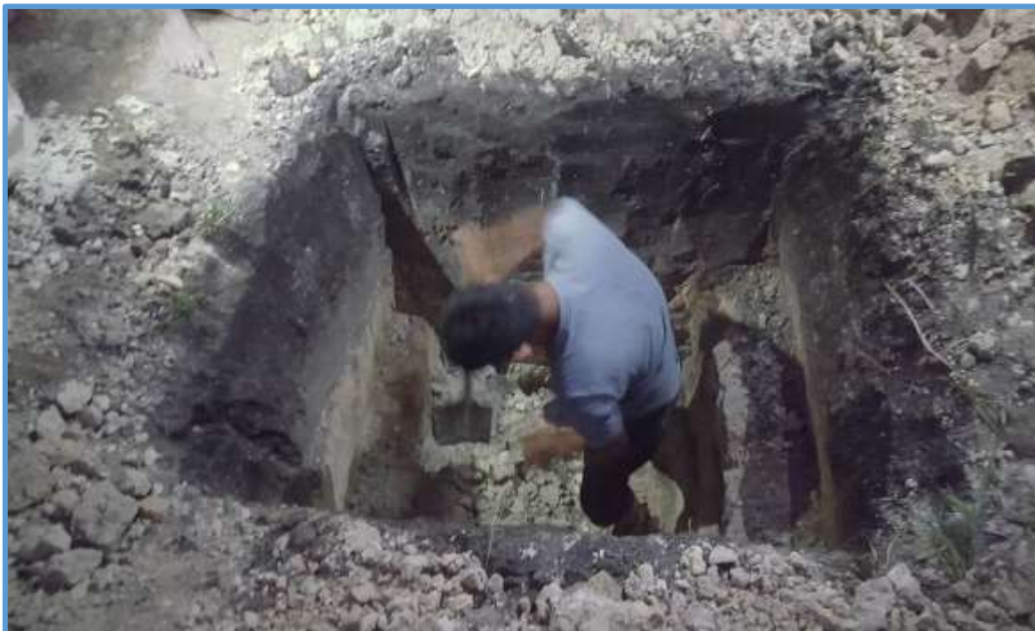
Foto 3: Véase en la imagen la continuación del trabajo de excavación de la primera calicata en el Jr. Ochame y Calle F hasta llegar a la altura promedio de 3.00 m; N: 9321069, E:268645, A: 897 m.s.n.m.
