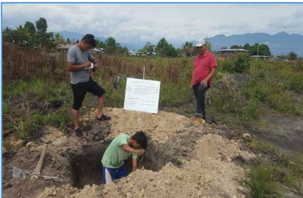
Foto 12: Véase en la imagen la excavación de la cuarta calicata (C-04) en el Jr. El Pongo y Calle F; N: 9321085, E:269486, A: 902 m.s.n.m.
