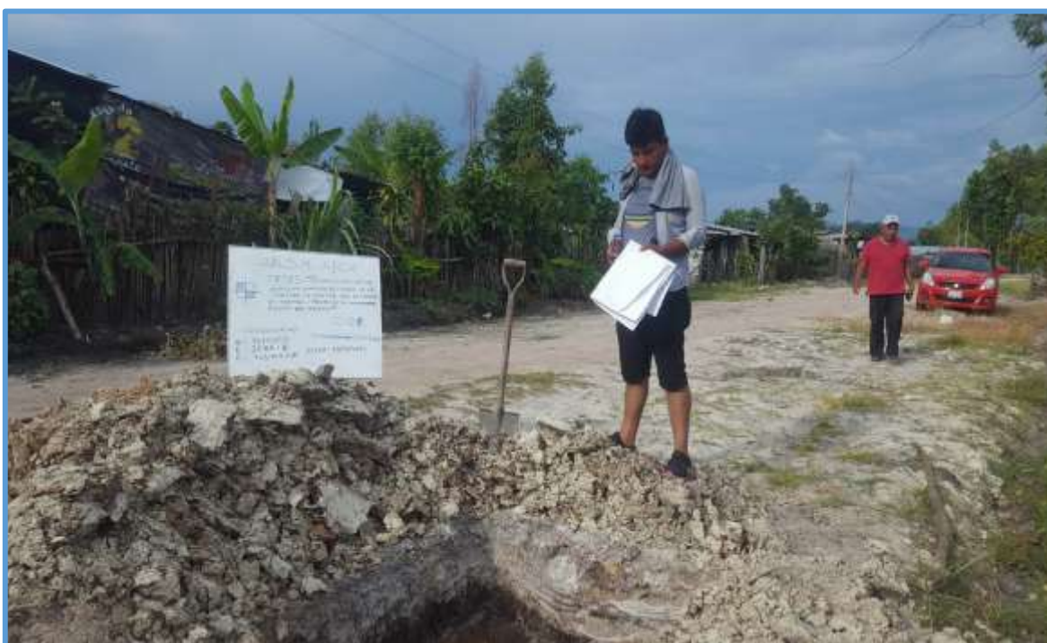
Foto 16: Véase en la imagen la excavación de la octava calicata (C-08) en el Jr. Ochame y Jr. Los Claveles; N: 9320952, E:268618, A: 903 m.s.n.m.
