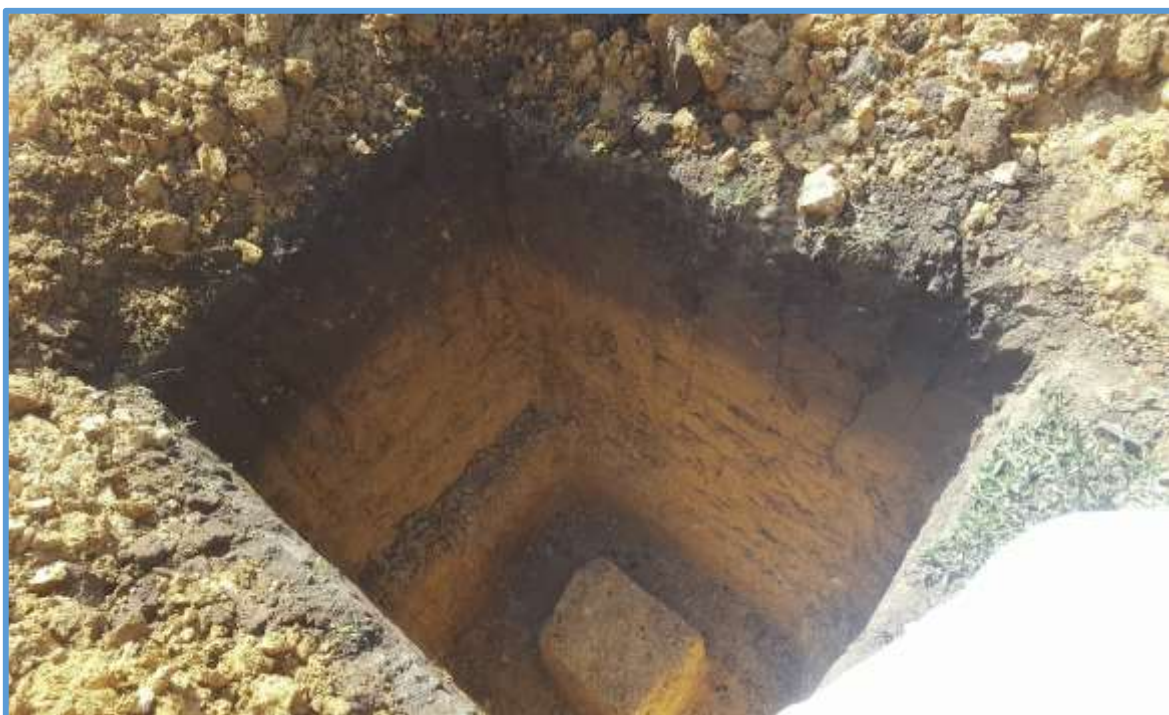
Foto 8: Véase en la imagen sacando la muestra inalterada para llevar a laboratorio y hacer los diferentes ensayos de la segunda calicata en el Jr. Oriente y Calle F; N: 9321073, E:269261, A: 900 m.s.n.m.
