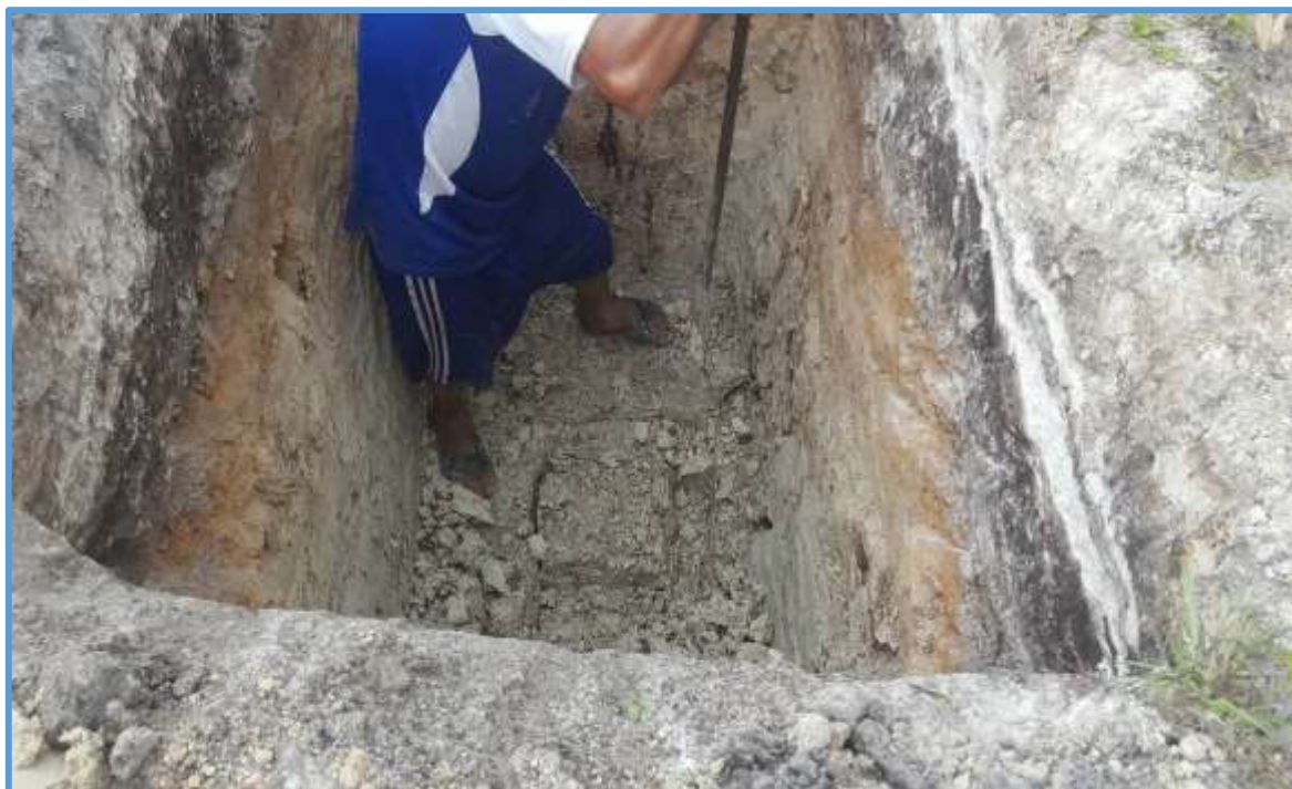
Foto 23: Véase en la imagen los diferentes estratos del suelo en la calicata (C-18) en el Jr. Prolongación Las Flores y Jr. El Pongo; N: 9320716, E:268990, A: 907 m.s.n.m.
