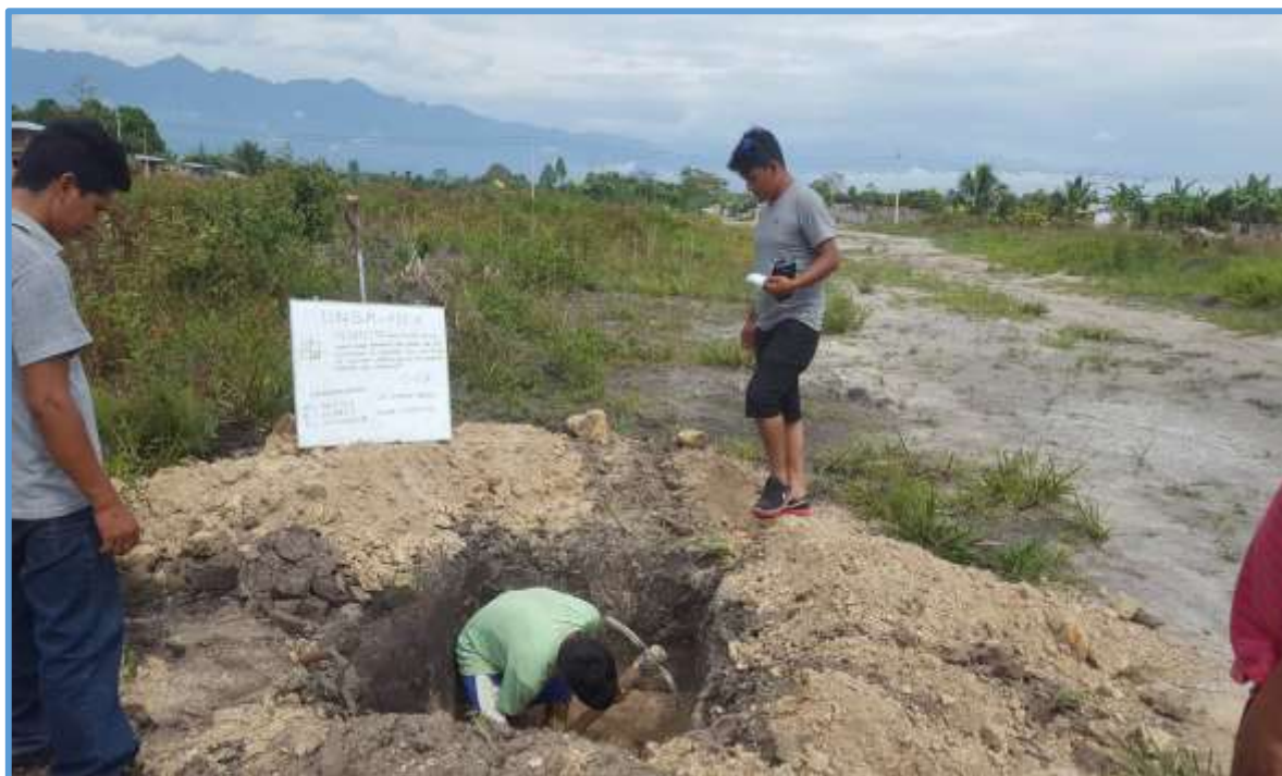
Foto 6: Véase en la imagen la excavación de la segunda calicata (C-02) en el Jr. Oriente y Calle F; N: 9321073, E:269261, A: 900 m.s.n.m.
