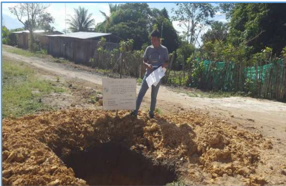
Foto 9: Véase en la imagen la excavación de la tercera calicata (C-03) en el Jr. Indoché y Calle F; N: 9321080, E:269372, A: 903 m.s.n.m.
