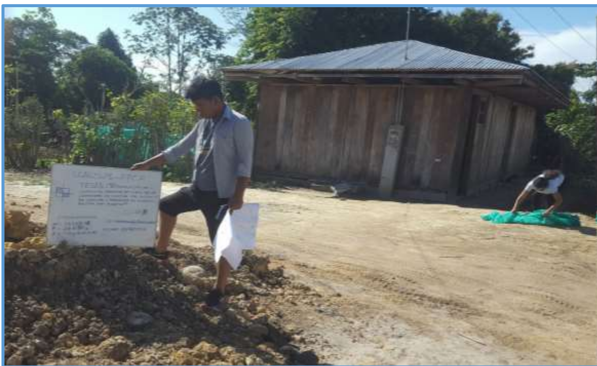
Foto 15: Véase en la imagen la excavación de la séptima calicata (C-07) en el Jr. El pongo y la Calle H; N: 9321018, E:268986, A: 905 m.s.n.m.
