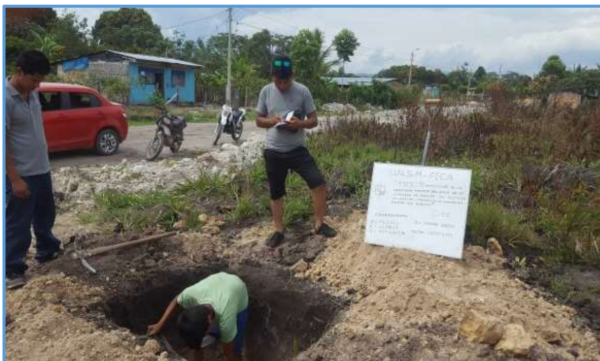
Foto 2: Véase en la imagen la excavación de la primera calicata (C-01) en el Jr. Ochame y Calle F; N: 9321069, E:268645, A: 897 m.s.n.m.
