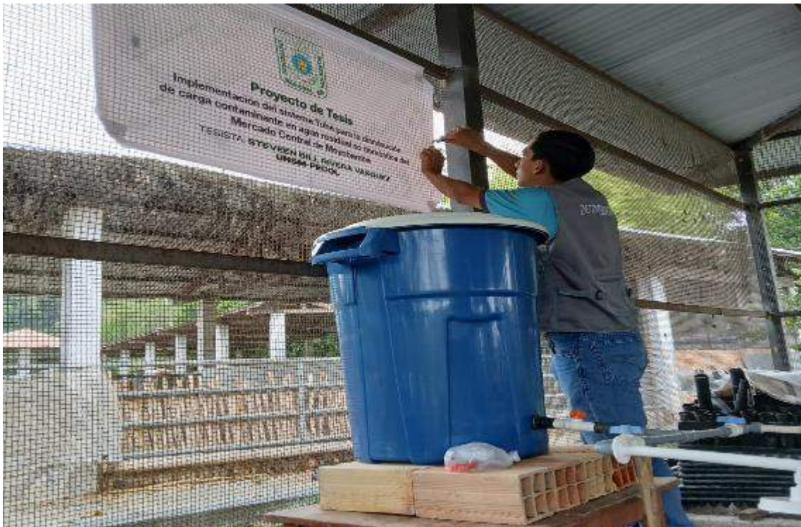
Fotografía 1. Acondicionamiento del área de ubicación del sistema Tohá.
