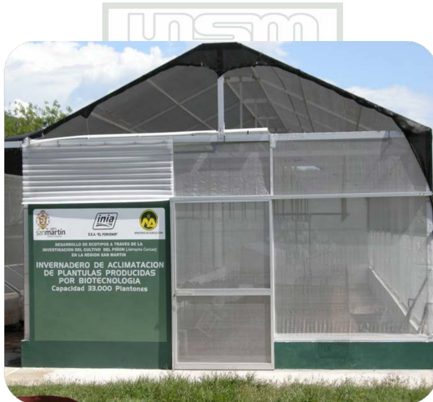
FOTO 1: INVERNADERO DE BIOTECNOLOGIA VEGETAL (INIA).
