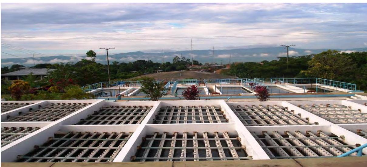
El agua filtrada es almacenada en el reservorio de 2,500m<sup>3</sup> previa desinfección con cloro-gas.
