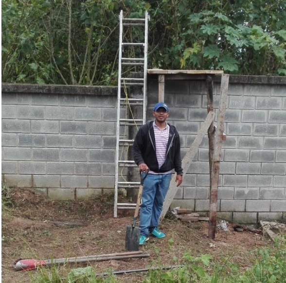
Foto 01: Acondicionamiento del área y construcción de plataforma para el tanque elevado.
