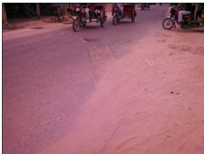
Figura 101. Cuadra 15 – Parcheo y Pulimento de agregados.
