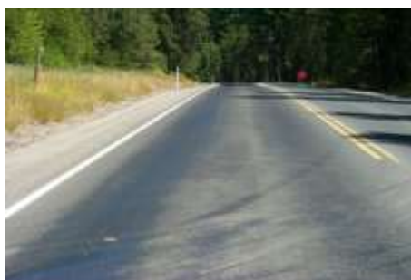
Figura 15. Exudación con nivel de severidad bajo o leve.
