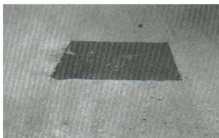
Figura 42. Parcheo y acometidas de servicio con nivel de severidad bajo o leve.
