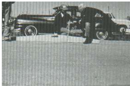
Figura 27. Depresión con nivel de severidad bajo o leve.
