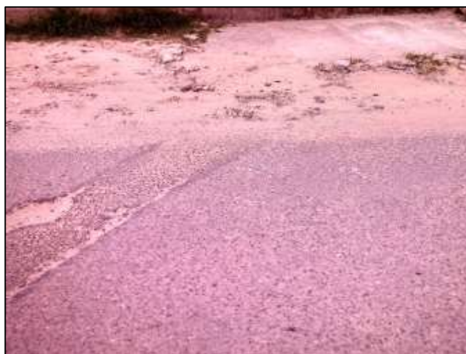
Figura 102. Cuadra 15 – Parcheo, bache (hueco) y pulimento de agregados.
