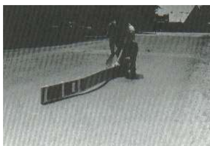
Figura 55. Desplazamiento con nivel de severidad leve.
