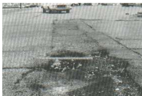
Figura 44. Parcheo y acometidas de servicio con nivel de severidad alta.
