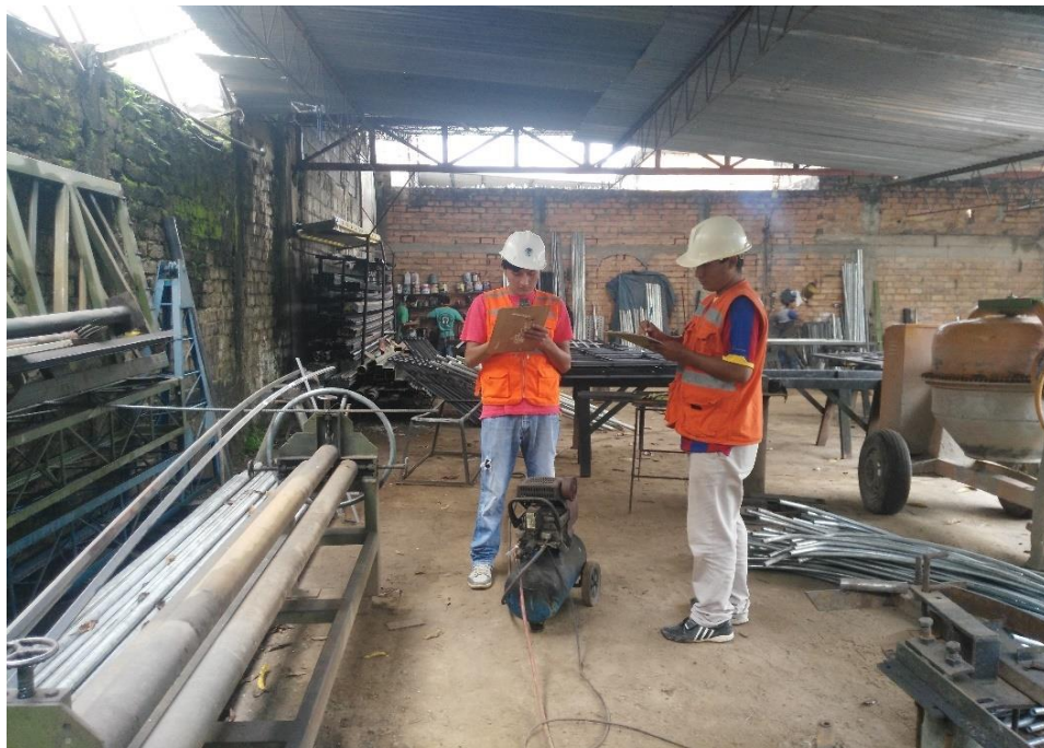
Foto N° 2. Inspección de seguridad – equipos.
