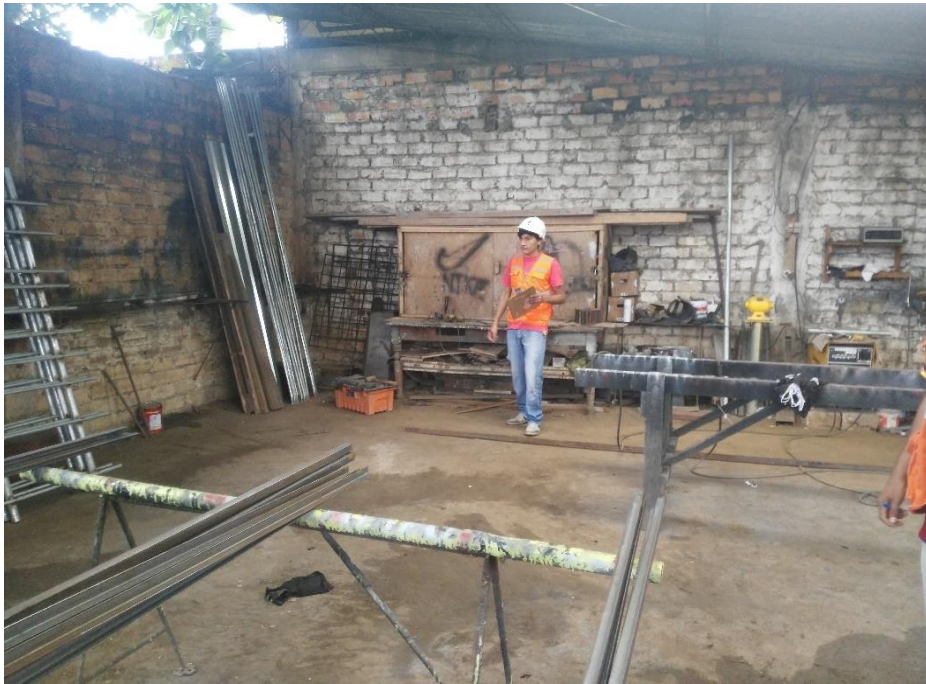
Foto N° 1. Inspección de Seguridad – Patio de trabajo.
