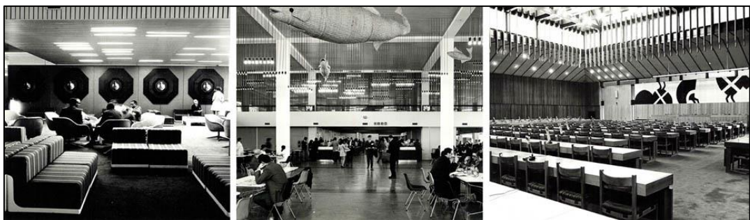
Imagen 21. Interior del edificio cultural en sus inicios antes de ser remodelado. C.C. Gabriela Mistral, Santiago de Chile. (Nico Saieh – Fotografía. Por: www.archdaily.pe . 2010)
