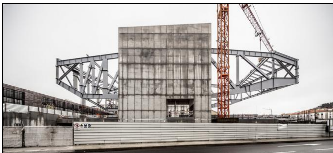
Imagen 2. Proceso Constructivo C.C en Castelo Branco, Portugal. (Adrià Goula – Fotografías. Por: www.metalocus.es 2013. Recuperado de: http://www.metalocus.es/es/noticias/centro-cultural-en-castelo-branco-por-josep-lluis-mateo . 2013)
