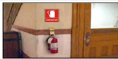
Imagen 61: Los extintores deberán estar instalados en sus respectivos porta extintores, ganchos, colgadores o gabinetes. (Fuente: Norma Técnica Peruana – NTP 350.043.01)
