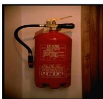
Imagen 61: Los extintores deberán estar instalados en sus respectivos porta extintores, ganchos, colgadores o gabinetes. (Fuente: Norma Técnica Peruana – NTP 350.043.01)
