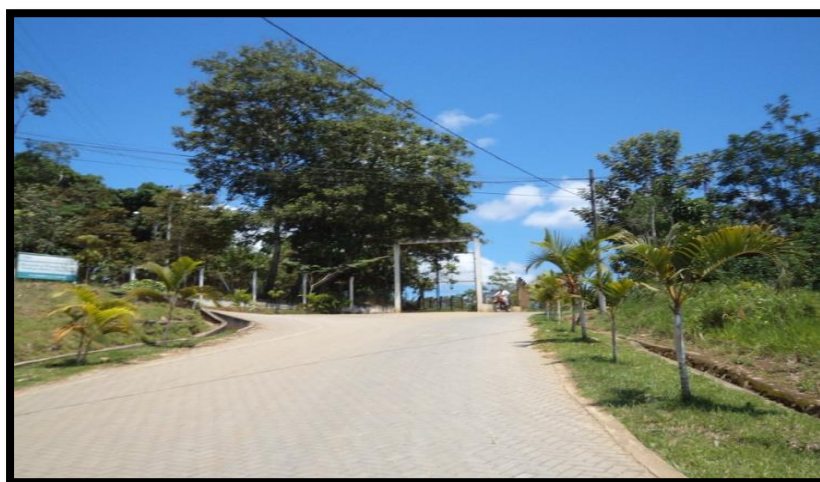
Imagen 18: Jirón proyecto adoquinado desde la cuadra 2 Fuente: elaboración propia - 2017
