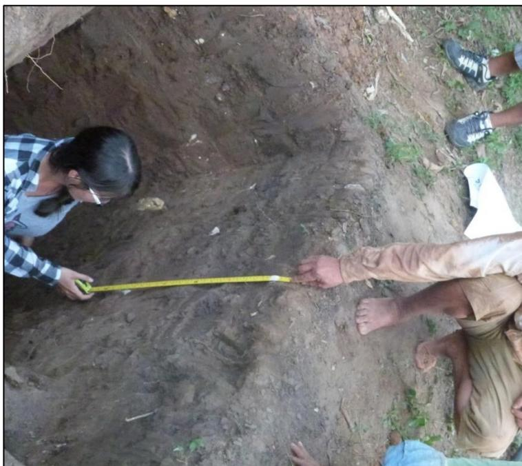
*Foto N° 02:* Se realizó la medición respectiva de la calicata, de la cual se obtuvo una profundidad de 3.00 m.
