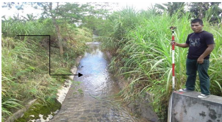
Figura 6. Canal el milagro revestido (Fuente: Elaboración propia.)
