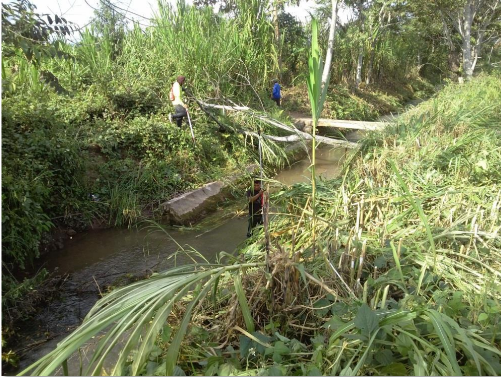
Levantamiento con mira y estación total
