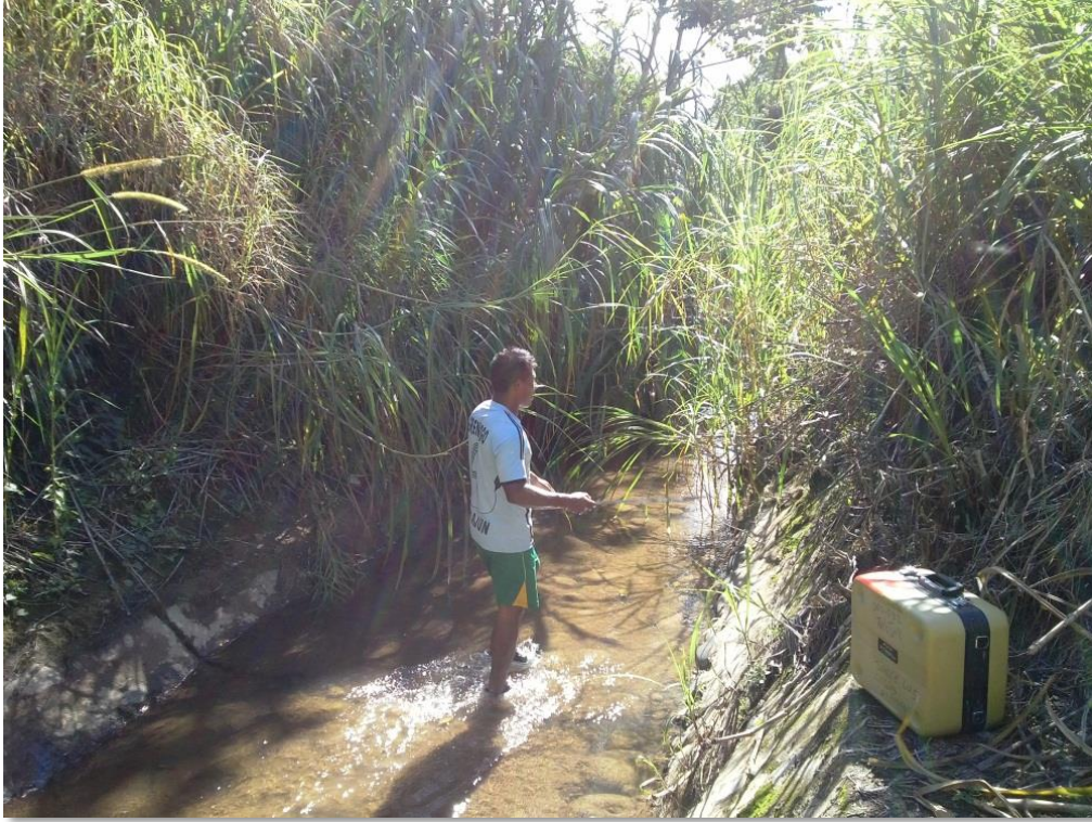
Estructura encontrada en el tramo del canal El Milagro
