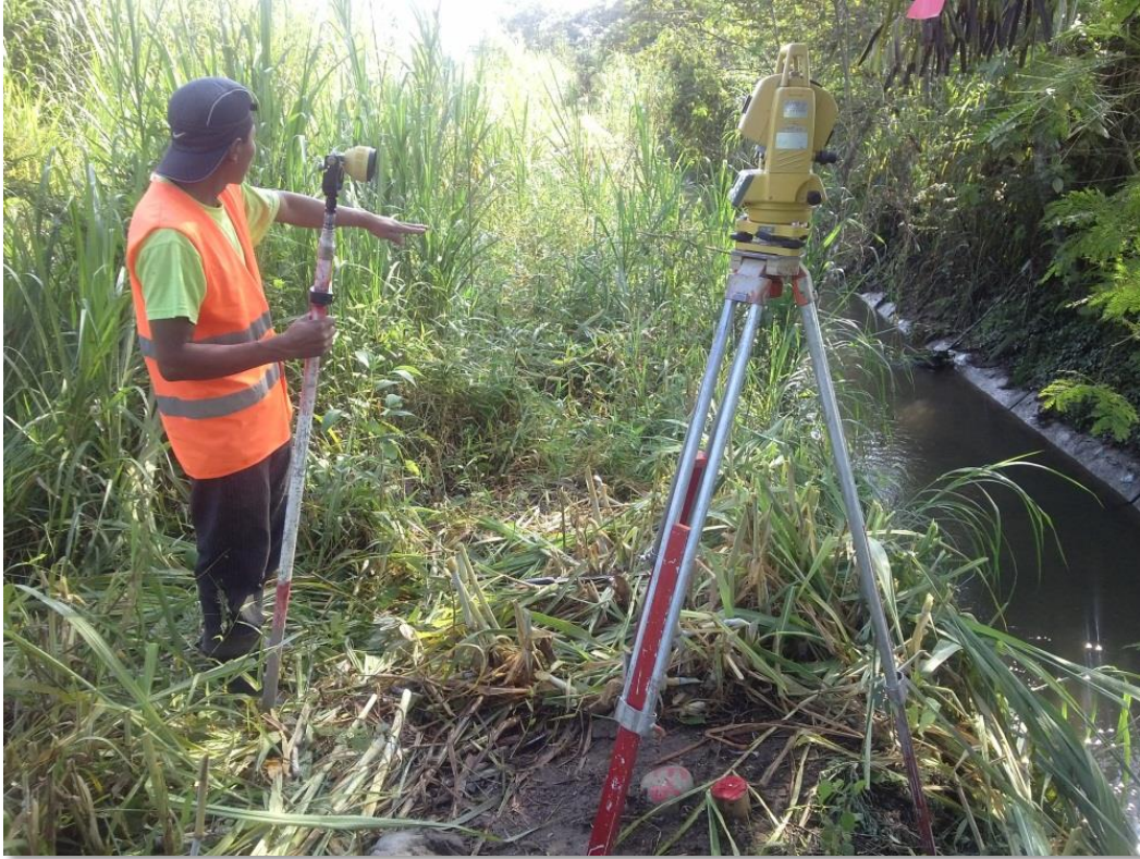
Estructura existente el Canal el Milagro
