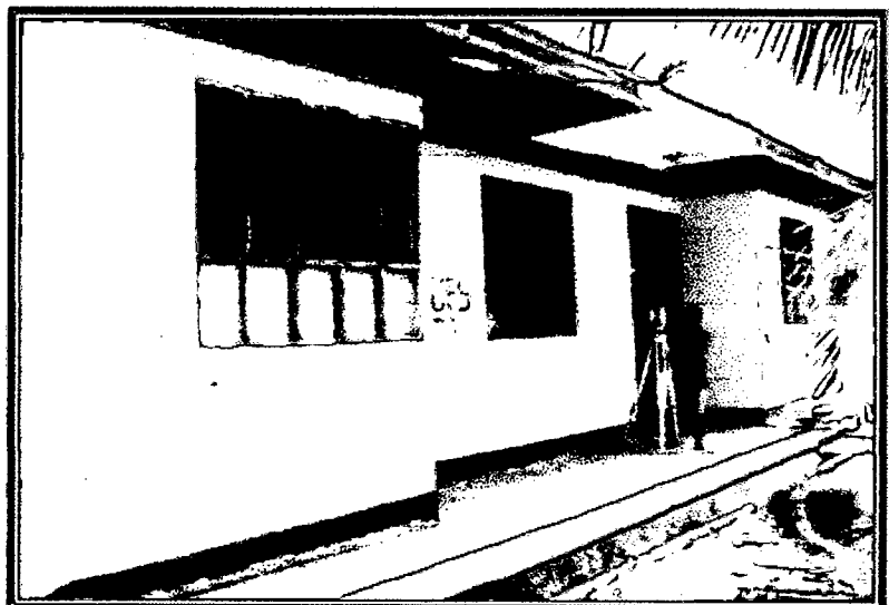
Se observa el Puesto de Salud de la localidad de Yarina
