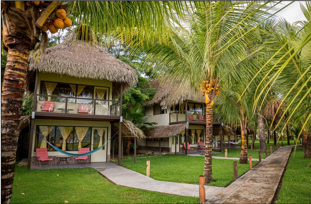
Figura 12. Infraestructura interna del hotel, Panduro y Rojas, 2018
