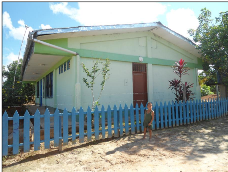
Figura 8: Puesto de Salud del C.P. de Miraflores
