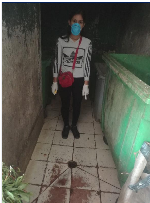
Figura 28. Condición de los pisos
