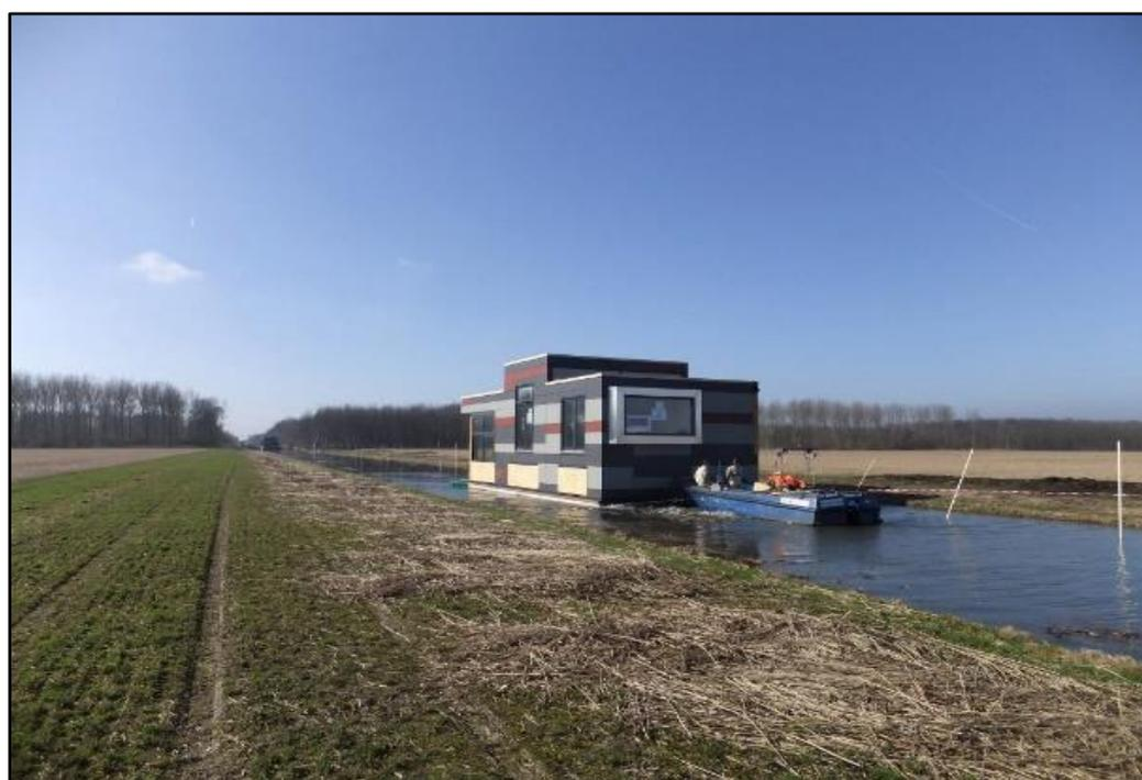
**Figura 8:**Traslado de los Módulos de vivienda
